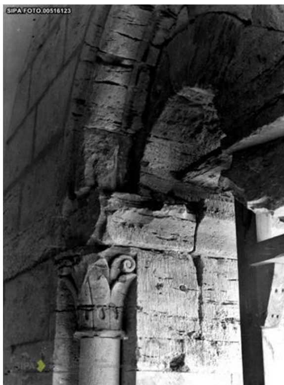
Fig 32. Janela da nave lateral Sul descoberta nos restauros dos anos 30, SIPA
