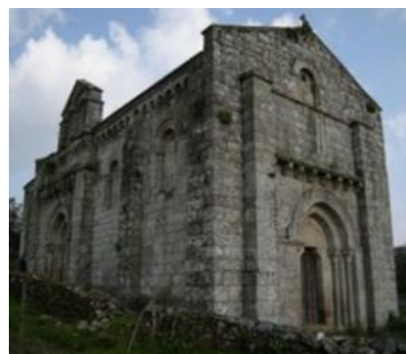
Fig 16. Fachada da Igreja de S. Pedro de Vilanova de Dozón, Galiza, Foto: Web (domínio público)
