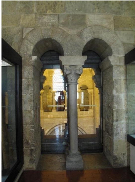
Fig 41. Vão geminado de passagem da galeria Sul para o trifório no primeiro tramo. Fotografia M.P.
