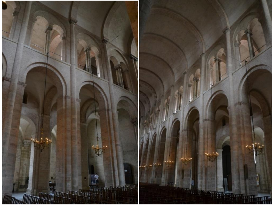
Fig 35. Alçado da nave central da basílica de Saint-Sernin de Toulouse, com vista da galeria (tribuna) sobre os arcos formeiros, e logo o arranque da abóbada e a inexistência de clerestório. Foto: Web (domínio público)
