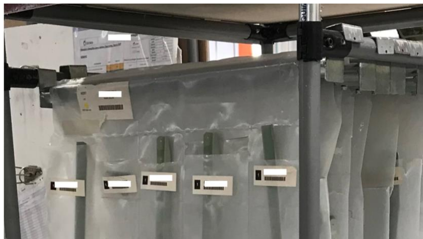
Figura 3.23 - Danos presentes no sistema, "Cortinas"
