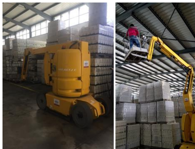
Figura 4.29 - Plataforma elevatória para apoio a instalação de placas
