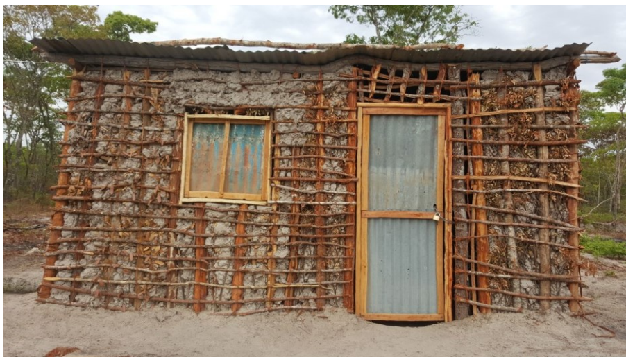
Figura 2.22-Habitação de tabique de terra ou pau-a-pique em que a estrutura resistente de troncos e ramos de madeira é visível por ter sido preenchida pelo interior e a parte exterior se ter degradado. A cobertura é feita com uma chapa flexível de alumínio. Luena, Moxico, Angola (Caso de estudo 3)[Créditos: Henriques R.]
