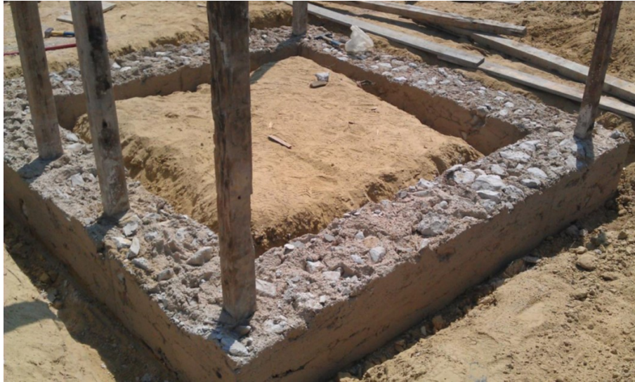
Figura 2.36-Prumos de madeira encastrados na fundação das paredes da célula em betão ciclópico (Carneiro et al., 2017).
