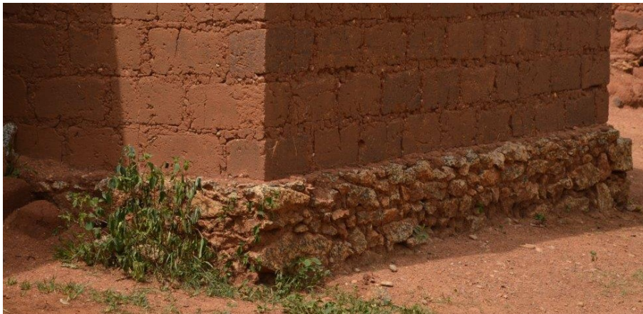
Figura 2.14-Soco de uma edificação de adobe, Kwanza Sul, Angola (caso de estudo 1)[créditos: Poulson S.].
