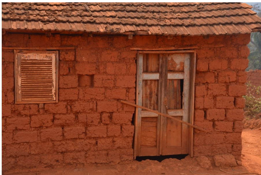
Figura 2.5-Habitação em adobe em que se pode observar tábuas de madeira maciça nos aros dos vãos da janela e da porta Kwanza-sul, Angola [créditos: Poulson J.].
