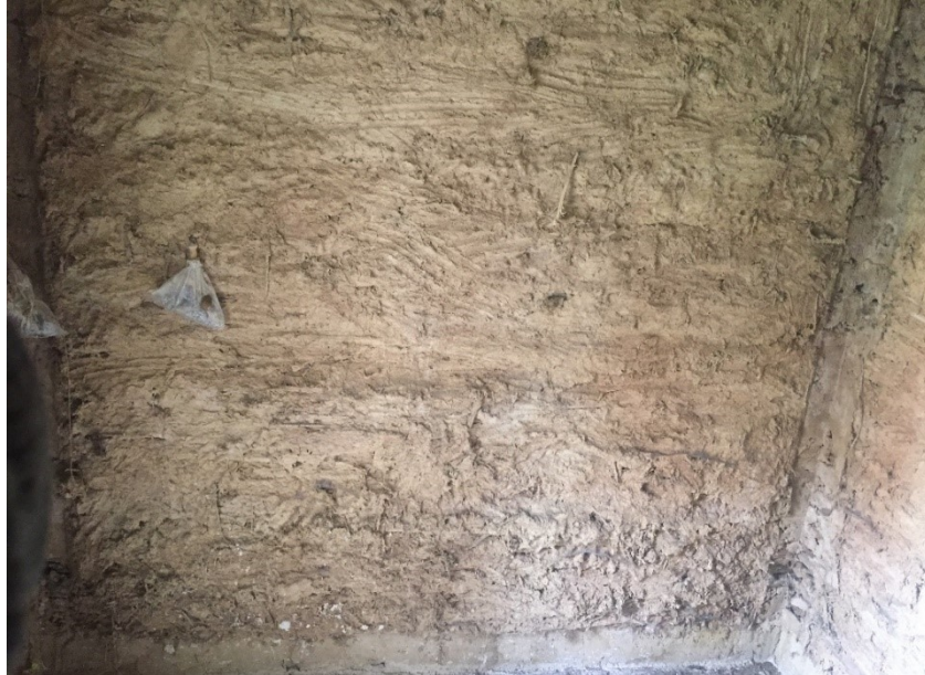
Figura 4.7-Parede interior sul em bom estado de conservação.
