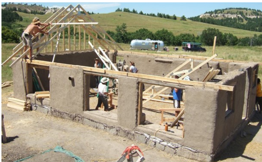
Figura 2.32- Construção de uma cobertura de edifício com paredes de cob [w9].
