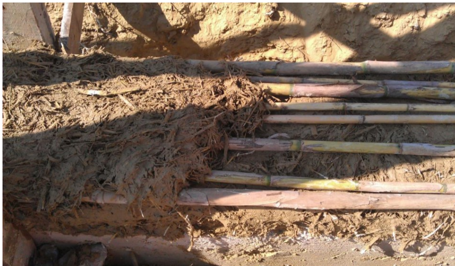
Figura 2.33-Parede de ReedCob da célula durante a construção em que são visíveis as canas e a argamassa com fibras (Carneiro et al. 2017).
