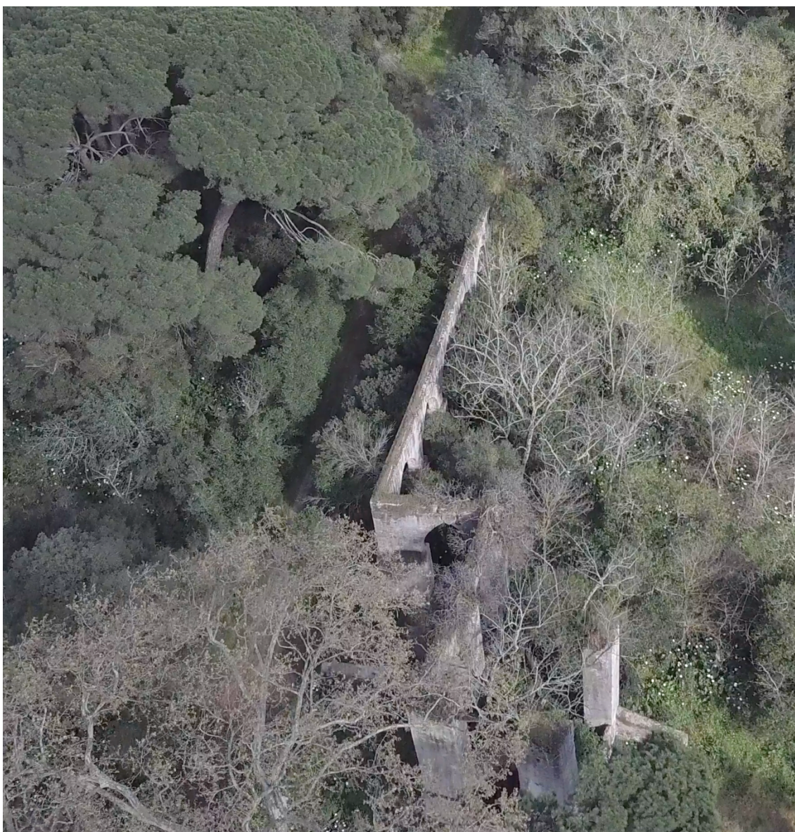
Figura 35. Vista aérea do Aqueduto da Quinta da Princesa. Autora, 2020.
