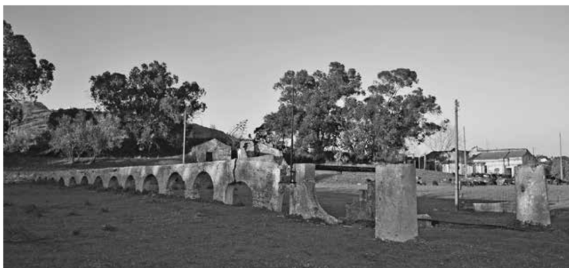
Figura 42. Quinta da Salema de Baixo e seu sistema hidráulico composto por poço, aqueduto e tanque. Fernandes, 2018.
