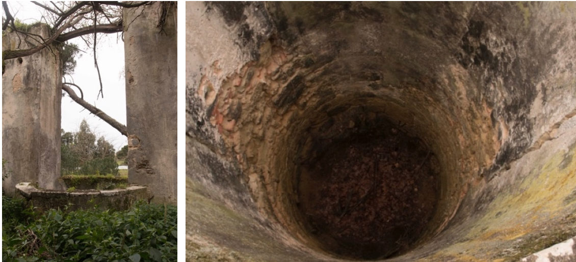
Figura 31. Poço conectado ao aqueduto da Quinta da Princesa. Autora, 2020.
