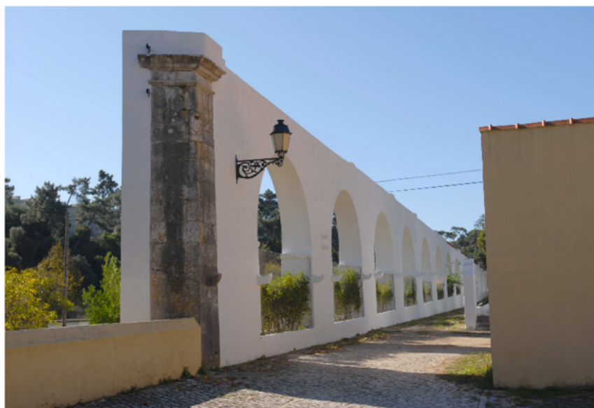
Figura 38. Aqueduto do Palácio Real do Alfeite em 2008. Ao contrário de outras estruturas hidráulicas da região, este aqueduto é bem conservado.
