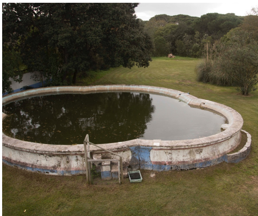
Figura 43. Tanque de rega localizado próximo ao muro que limita a quinta com a Rua Dom Infante Augusto. Detalhe para a jardineira existente em sua extremidade. Autora, 2020.
