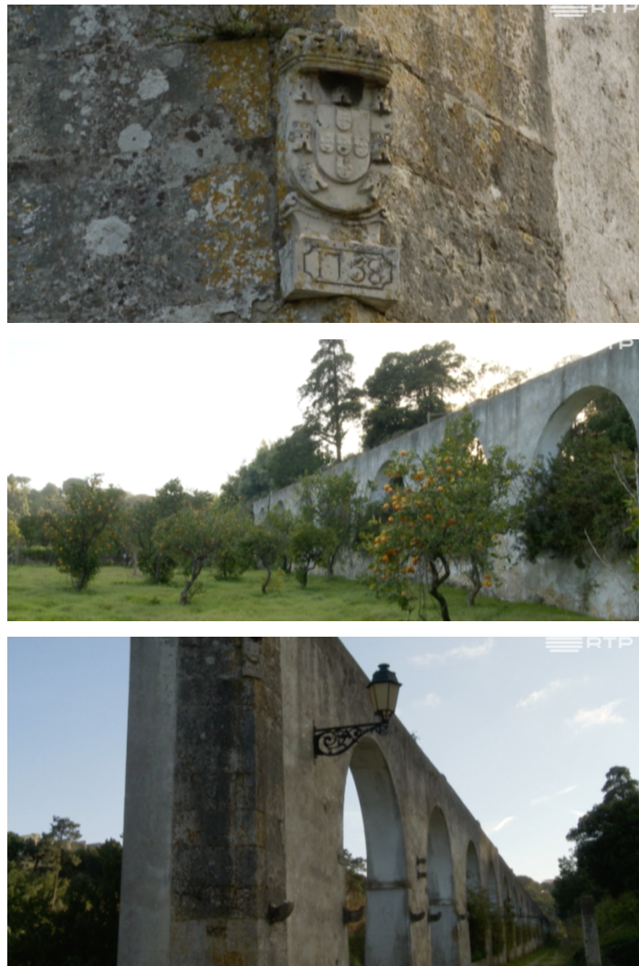
Figura 37. Aqueduto da Quinta Real do Alfeite. RTP, https://www.rtp.pt/play/p5656/e403813/visita-guiada-alfete-aqueduto-fotos
