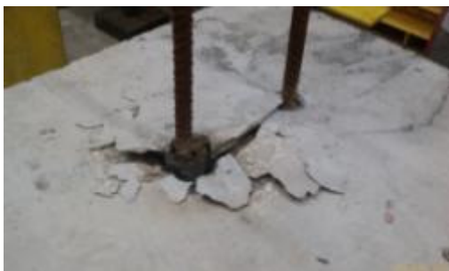
Figura 4.73 - Rotura por aderência
