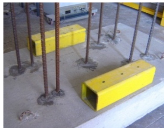
Figura 4.14 - Colocação de perfis metálicos
