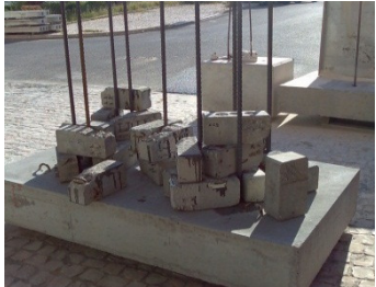
Figura 4.11 - Selagem dos varões
