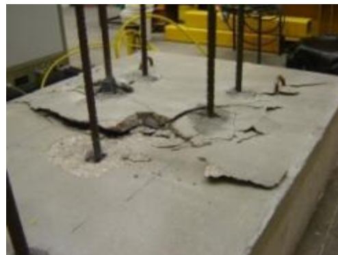
Figura 4.50 - Rotura pelo cone de betão
