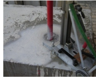
Figura 4.10 - Furação do betão
