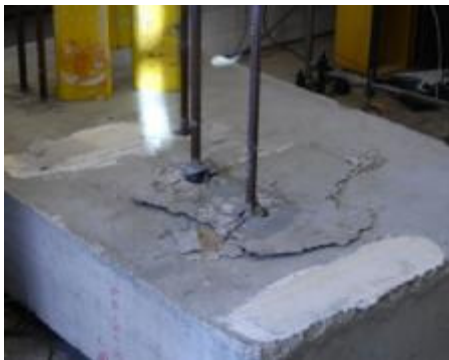
Figura 4.53 - Rotura pelo cone de betão
