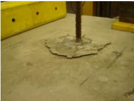
Figura 4.29 - Rotura por aderência
