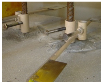
Figura 4.15 - Colocação de deflectómetros para medição de deslocamentos
