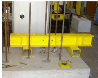
Figura 4.16 - Colocação de viga transversal
