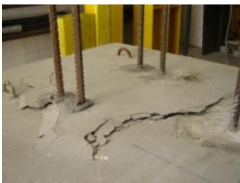
Figura 4.37 - Rotura pelo cone de betão
