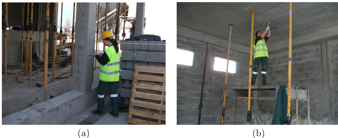
Figura 3.11: Ensaio esclerométrico à estrutura: (a) num pilar (orientação = 0^\circ ); (b) na lage (orientação = 90^\circ ).
