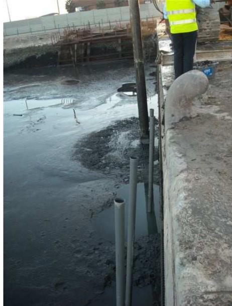
Figura 4.2 – Pormenor dos tubos de PVC colocados após a execução dos painéis CSM teste, na obra do Jardim do Tabaco (Dias, 2009)
