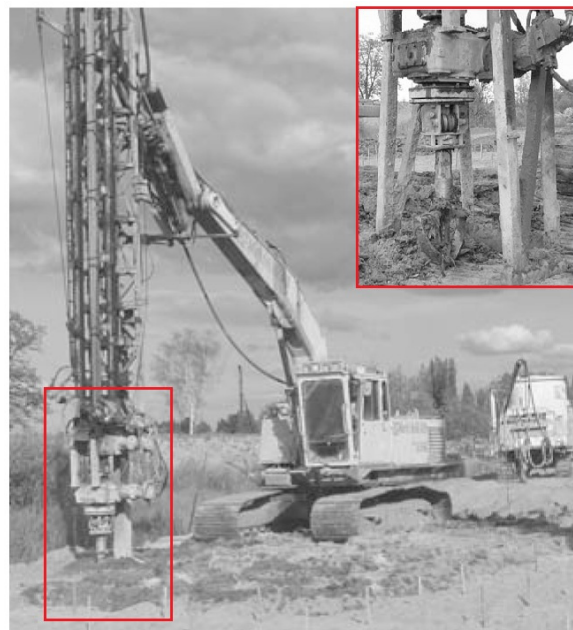
Figura 2.4 – Equipamento utilizado no processo construtivo LCC (adaptado de Topolnicki, 2004)
