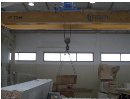
Figura 3.20: Descarga dos blocos por ponte 25T
