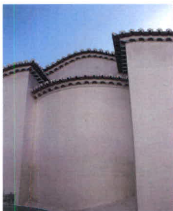
Vista exterior da abside voltada a nascente Igreja de Santo Amaro de Beja (imagem do site da DGEMN)
