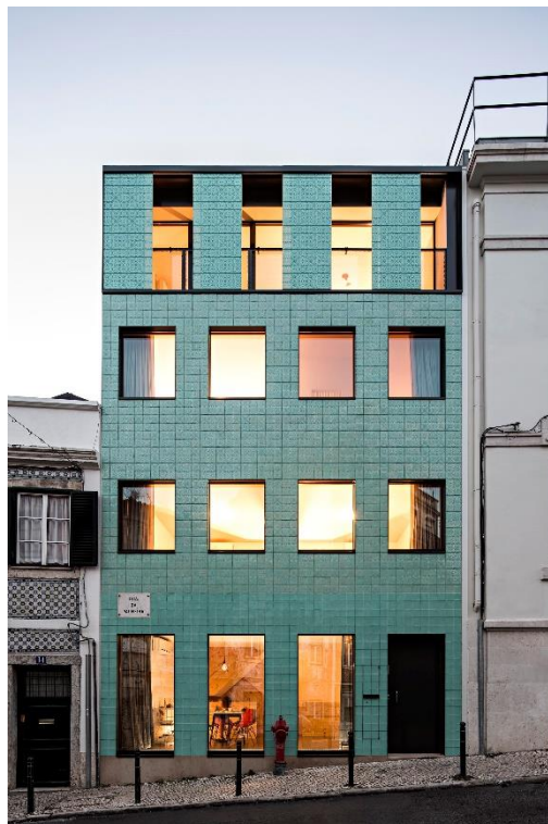
Figura 4-2: Fachada principal virada para a Rua da Palmeira
