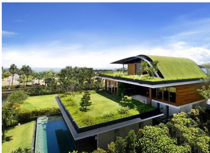
Figura 2-2 Telhados verdes incorporados nas construções ( http://blog.cerbras.com.br/index.php/confir-as-tendencias-em-construcao-sustentavel/ )
