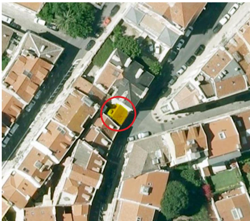
Figura 4-3: Vista aérea sobre a envolvente do edifício
