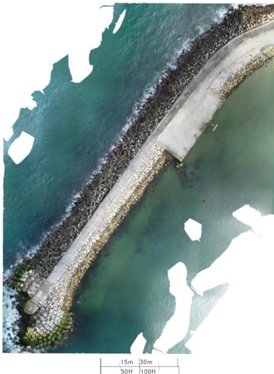
Figura 25. Ortomosaico do molhe inteiro, com algumas oclusões na parte da água, onde se identificam alguns blocos lançados perto da zona do cais.
