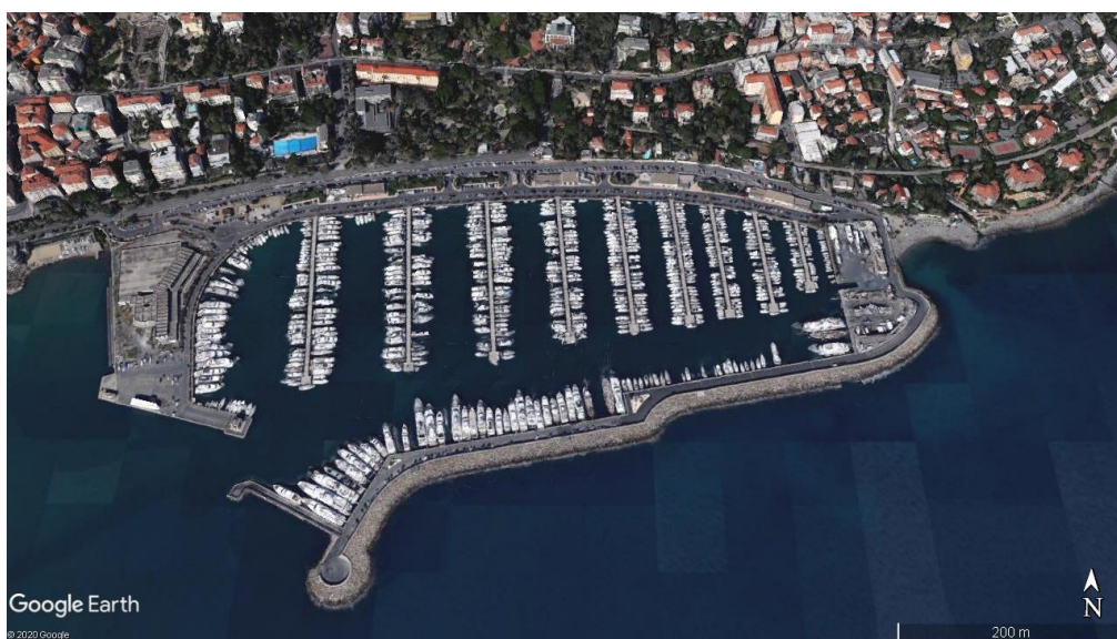
Figura 15. Quebra-mar de um porto privado em Sanremo, Itália (Google Earth Pro, 2020)
