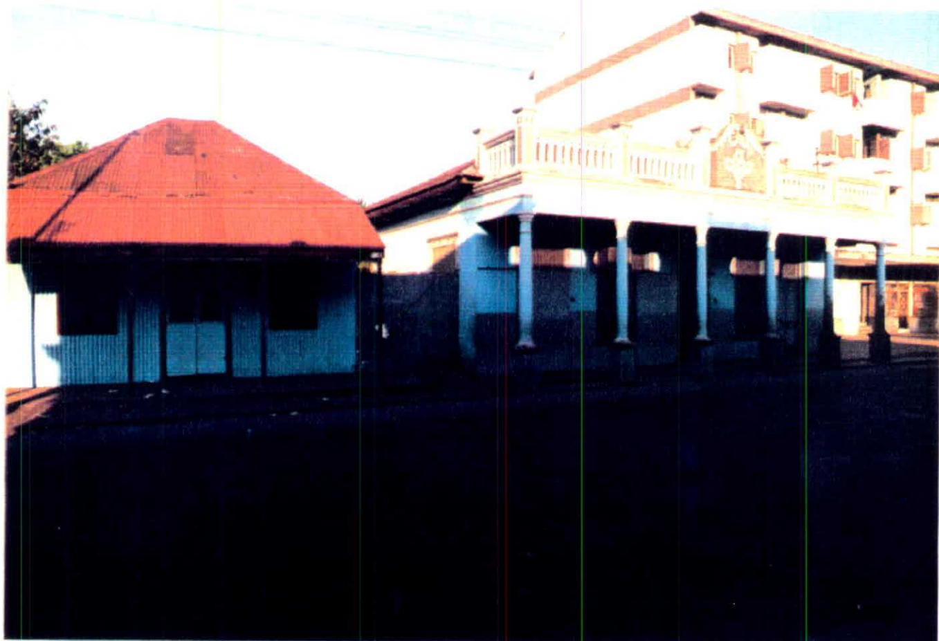
Casa de zinco onde esteve instalado o Instituto Negrófilo no bairro do Xipamanine.
