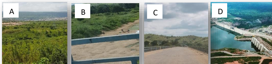
Figura 33- Província de Malange, Município de Cacuso e percurso de Luanda para Malanje (A, B e C). Barragem A Lauca situada em Cacuso (D). Fotografias de Alice Cardoso, 2018 (A, B e C) e Fotografia gentilmente cedida pelo Sr. Engenheiro Elias Estevão (D), 2018
