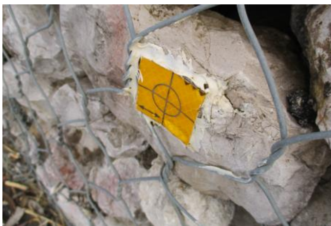
Figura 6.6 - Imagem de alvo topográfico instalado num bloco – representa pouca precisão aquando da sua leitura. Fotografia cedida pela IP.
