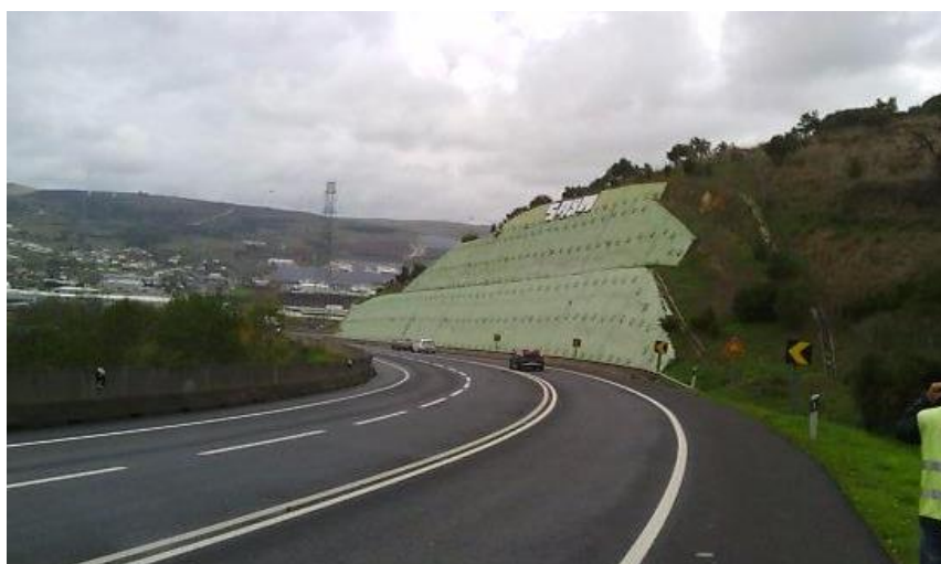
Figura 6.19 - Imagem da OC com ID 33, uma parede ancorada na proximidade da OC com ID 32, e com características estruturais iguais à OC com ID 32, mas altura muito superior. Fotografia cedida pela IP.
