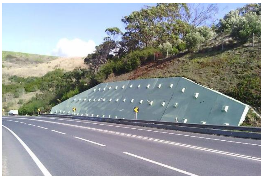
Figura 6.18 - Imagem da OC com ID 32, uma parede ancorada que protege a EN 115-5. Fotografia cedida pela IP.
