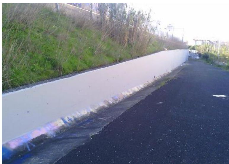
Figura 6.16 - Imagem da OC com ID 218, um muro de betão armado que suporta a via IC 17; a estrutura decresce muito em altura ao longo do seu desenvolvimento. Fotografia cedida pela IP.
