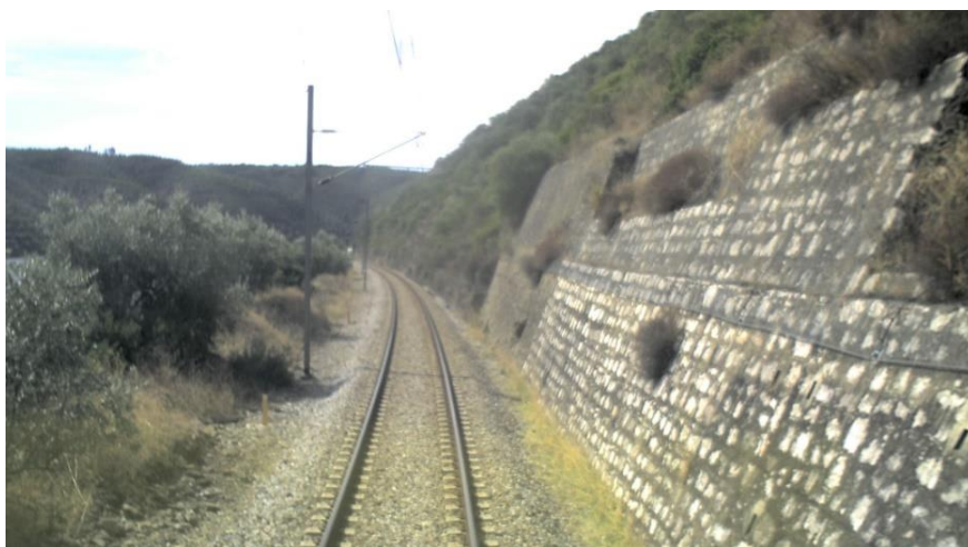
Figura 6.9 - Imagem da OC com ID 51175, uma solução mista de muro de alvenaria e talude pregado/ancorado com redes metálicas de encaminhamento, que protegem a via. Fotografia cedida pela IP.
