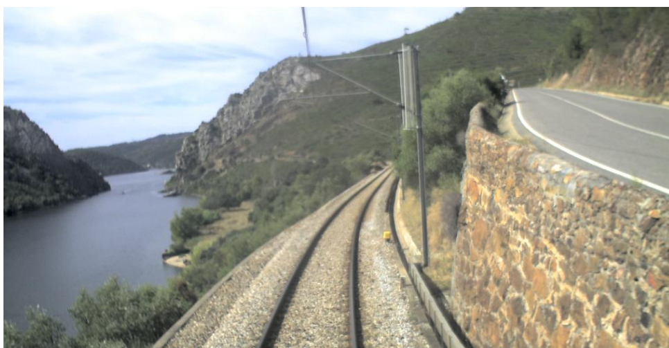
Figura 6.8 - Imagem da OC com ID 50213, um muro de alvenaria que protege a linha férrea e suporta uma rodovia. Fotografia cedida pela IP.
