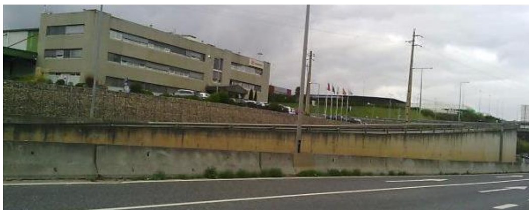
Figura 6.15 - Imagem da OC com ID 39, um muro de betão armado que protege a EN 115-5; a estrutura decresce muito em altura ao longo do seu desenvolvimento. Fotografia cedida pela IP.
