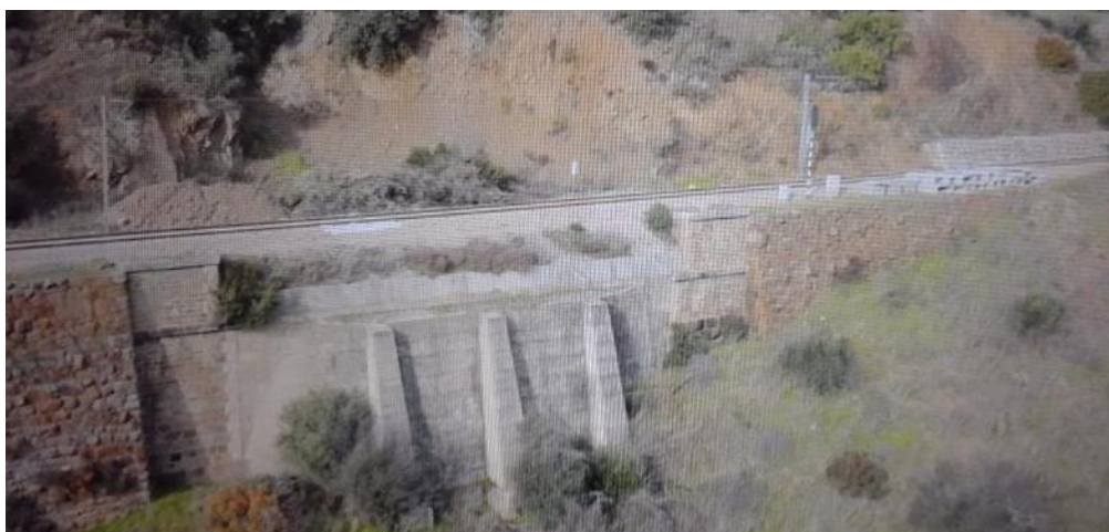
Figura 6.17 - Imagem da OC com ID 51334, um muro de betão armado que suporta a Linha da Beira Baixa. Fotografia cedida pela IP.
