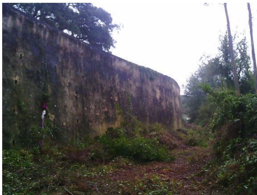
Figura 6.20 - Imagem de OC com ID 13, um muro de alvenaria a suportar a via. Fotografia cedida pela IP.
