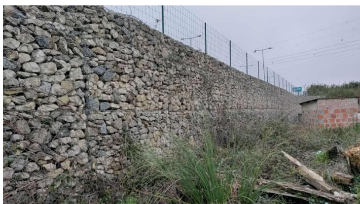
Figura 6.5 - Fotografia da OC com ID 31 – Muro de gabiões que suporta a via. Fotografia cedida pela IP.
