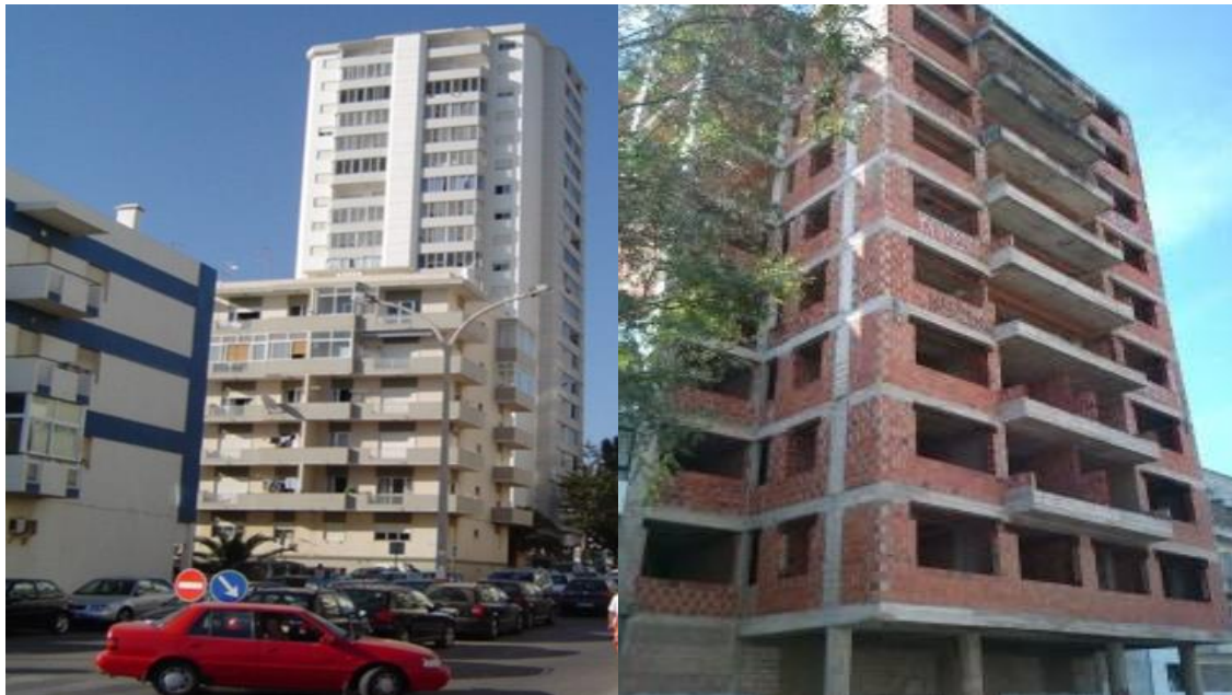
Figura 36: Torres Mira Mar e edifício em construção abandonado
