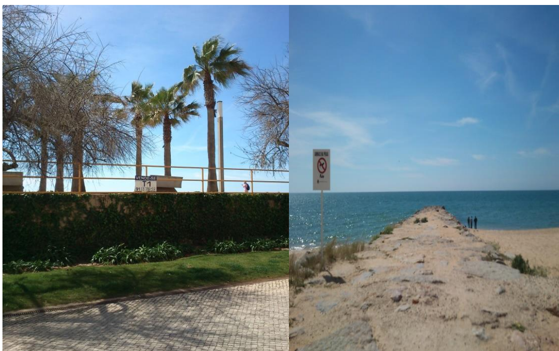
Figura 35: Muro de suporte da praia e molho de pedras contra galgamentos
