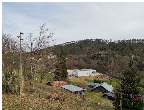
Figura 4.44 - ETAR em construção.
