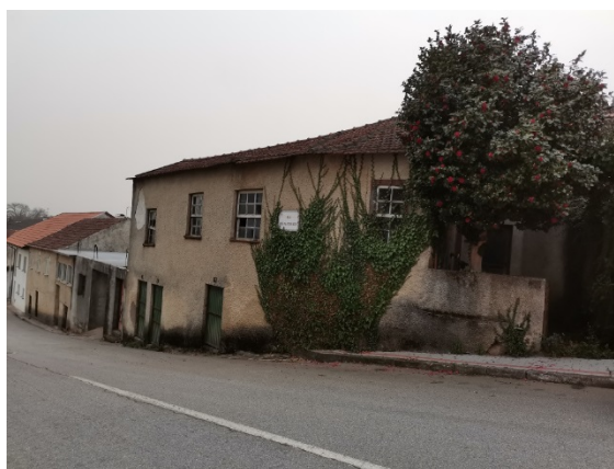
Figura 4.65 - Fotografia de edifício devoluto na Rua dos Santos Idos, Sátão.
