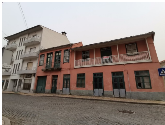
Figura 4.63 - Fotografia de edificado devoluto na Rua Dr. Hilário de Almeida Pereira, Sátão.
