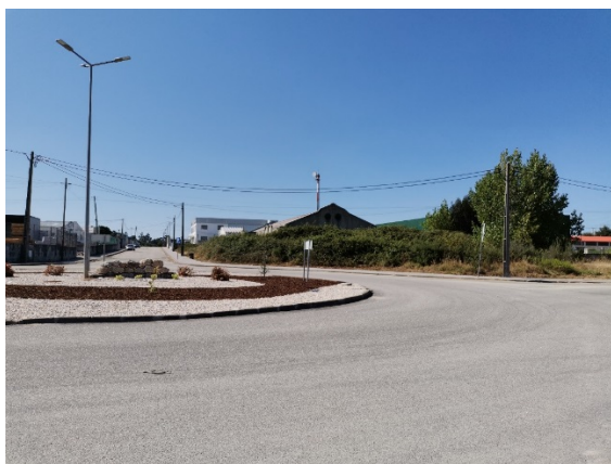
Figura 4.57 - Fotografia de edifício devoluto, junto ao estaleiro municipal.
