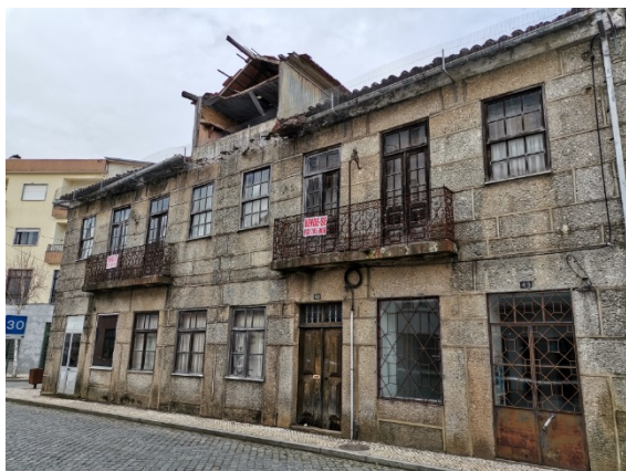
Figura 4.62 - Fotografia de edificado devoluto na Rua Dr. Hilário de Almeida Pereira, Sátão.
