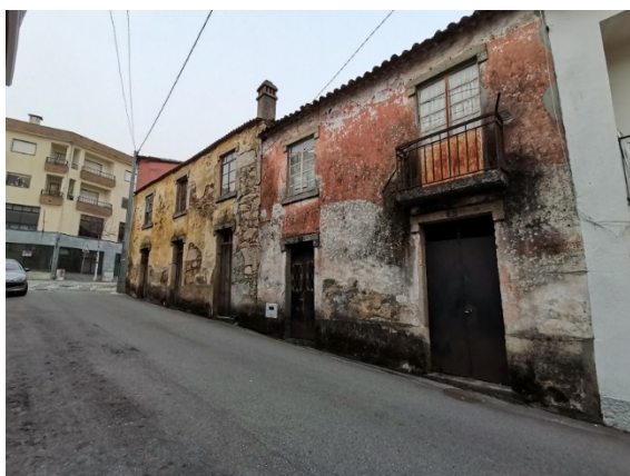
Figura 4.64 - Fotografia de edifício devoluto na Rua da Cadeia, Sátão.
