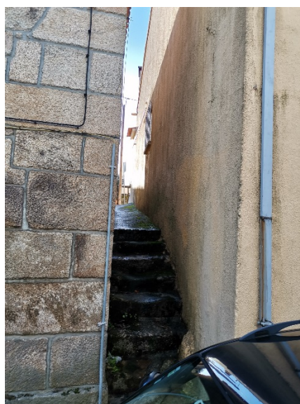
Figura 3.6 - Foto de escadas urbanas, Rua da Cadeia - Sátão.
