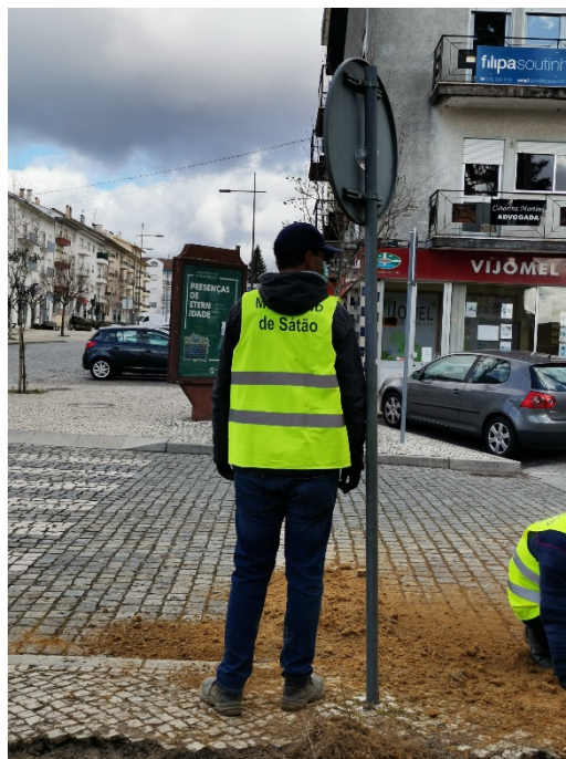
Figura 4.2 - Comparação entre a altura de sinal de trânsito com jardineiro municipal que trabalhava na obra de requalificação da Praça Paulo VI - Sátão.
