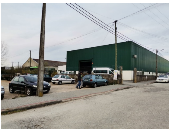
Figura 4.59 - Entrada principal do Estaleiro Municipal.
