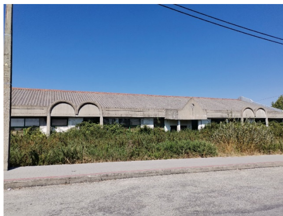
Figura 4.58 - Fotografia de edifício devoluto, junto ao estaleiro municipal.
