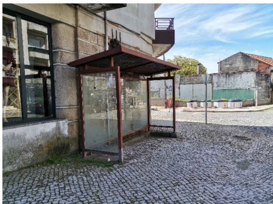
Figura 3.14 - Abrigo de autocarro na Rua Dr. Hilário Almeida Pereira.
