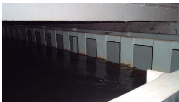
(c) Descarregador de superfície do reservatório elevado
