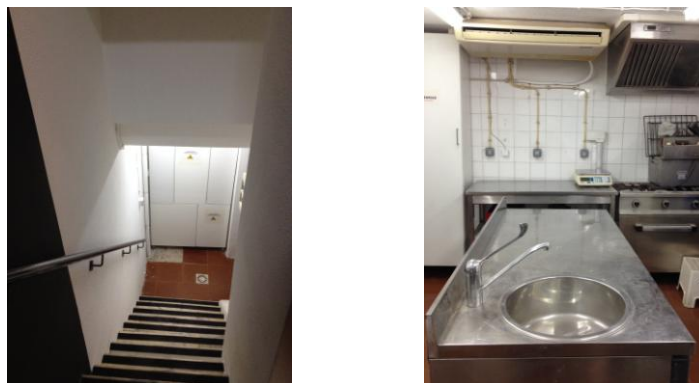
Figura 20 – Escada de acesso à cozinha e imagem da cozinha após a abertura (Autora, 2015).
