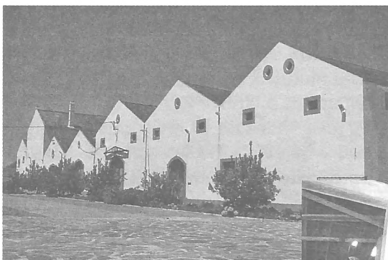
Fig. 7 - Adegas de Algeruz. Fachada do edifício, a Poente. Herdade de Algeruz - Palmela
