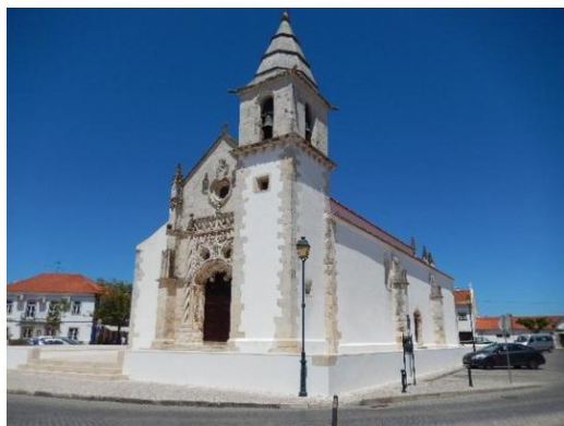
Fig. 19 – Vista geral da Igreja Matriz da Golegã
