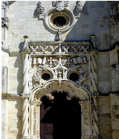
Fig. 21 - Pormenor da fachada da Igreja Matriz da Golegã
