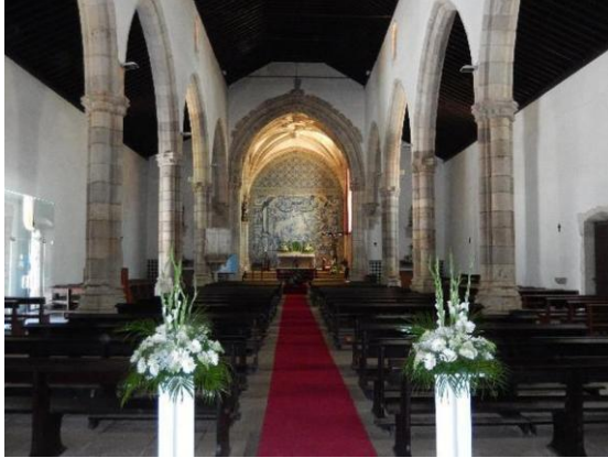
Fig. 3. Nave e Capela Mor da Igreja Matriz da Golegã 40
