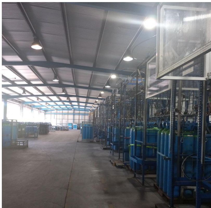
Figura 4.5 - Zona de enchimento
