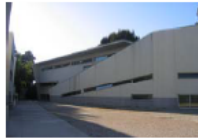
Fotog.1 - Foto do edifício
