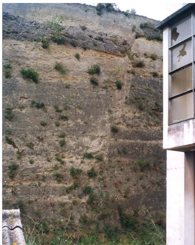
Figura V.9 - Aspecto calcarenítico do conjunto litológico que conforma a escarpa do extremo nordeste de Almaraz, sobranceira ao Tejo, e a ponte do Ginjal. Observa-se ainda pormenor de plano de falha que intersecta a divisão IVb de Cotter (fotografia de P.LAMAS).
