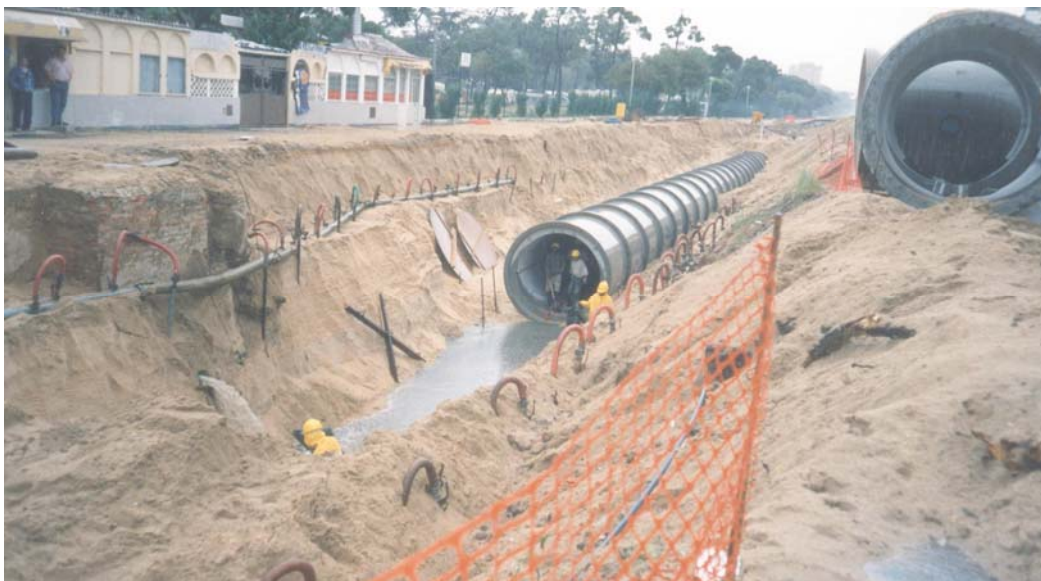
Figura VI.11 - Aspecto do decorrer das obras de fecho da vala da Alameda Atlântica, na Costa de Caparica, onde se pode observar o dispositivo montado para rebaixamento do nível de água nos Depósitos arenosos eólicos e costeiros.
