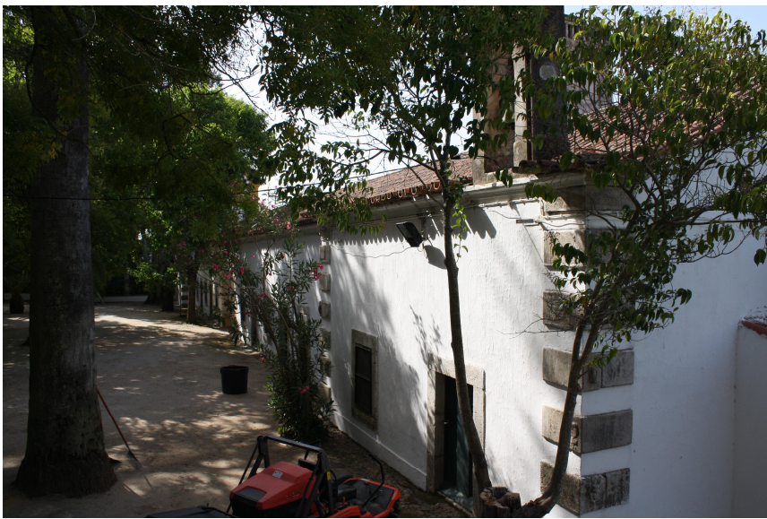
Fig. 19 – Edifício (a ponte) cuja fachada se orienta para o pátio central
