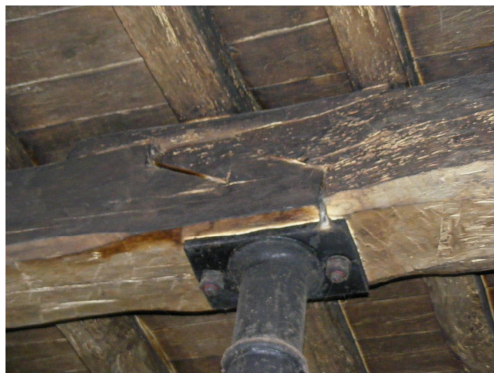
Fig. 43 – Convergência entre pilar de ferro e assemblagem do travejamento em madeira.
