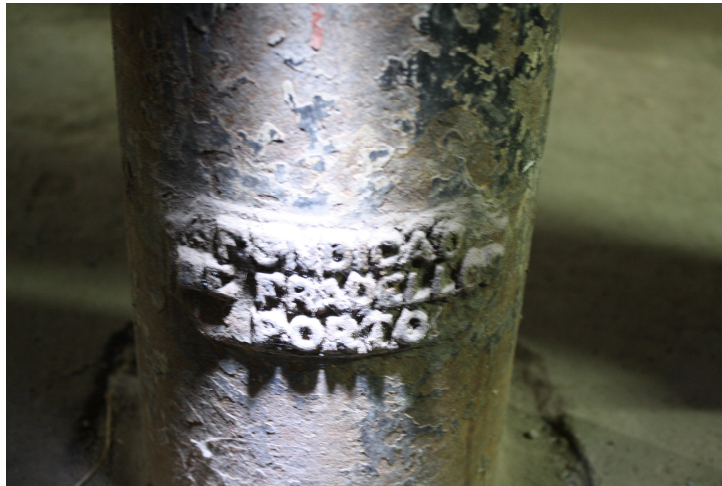
Fig. 42 – Marca da Fundição de Fradellos num dos pilares
