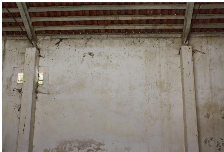
Fig. 48 – Parede interna de um dos armazéns
