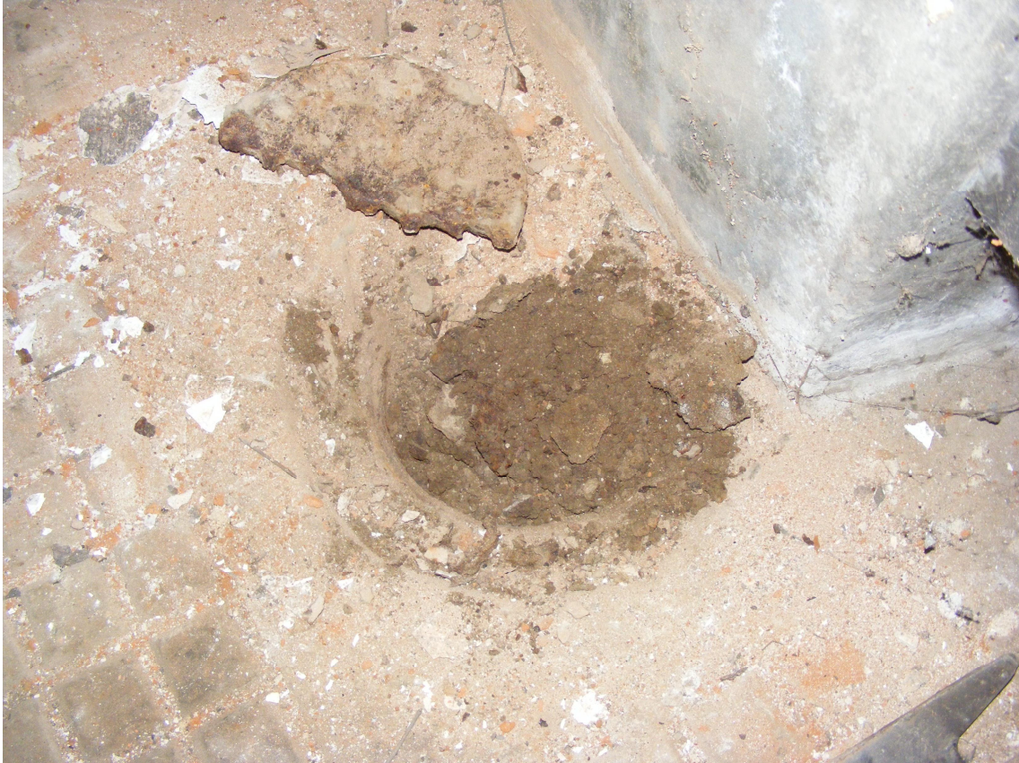
Fig. 38 – Esgoto para escoamento das águas.
