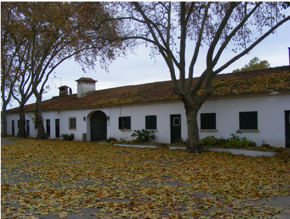
Fig. 51 – Fachada Noroeste das casas dos criados
