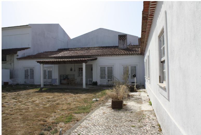
Fig. 16 – Fachada do edifício mais a norte [2a]
