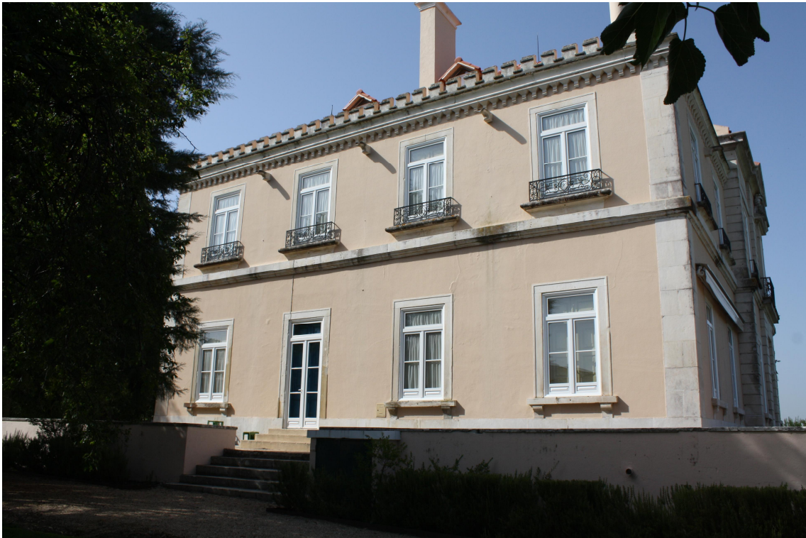
Fig. 9 – Fachada lateral do Palácio da Quinta da Alorna
