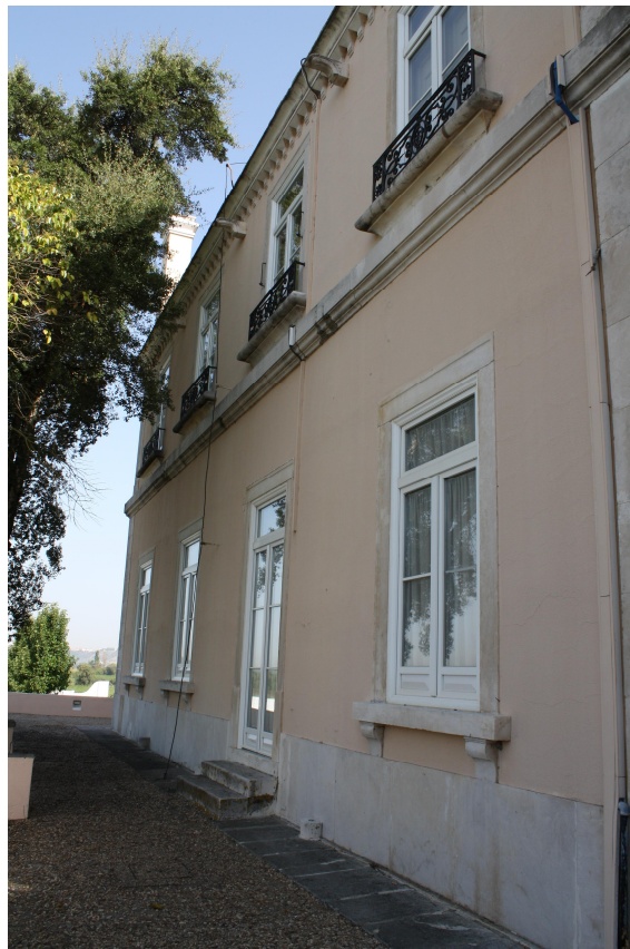
Fig. 10 – Porta da fachada lateral
