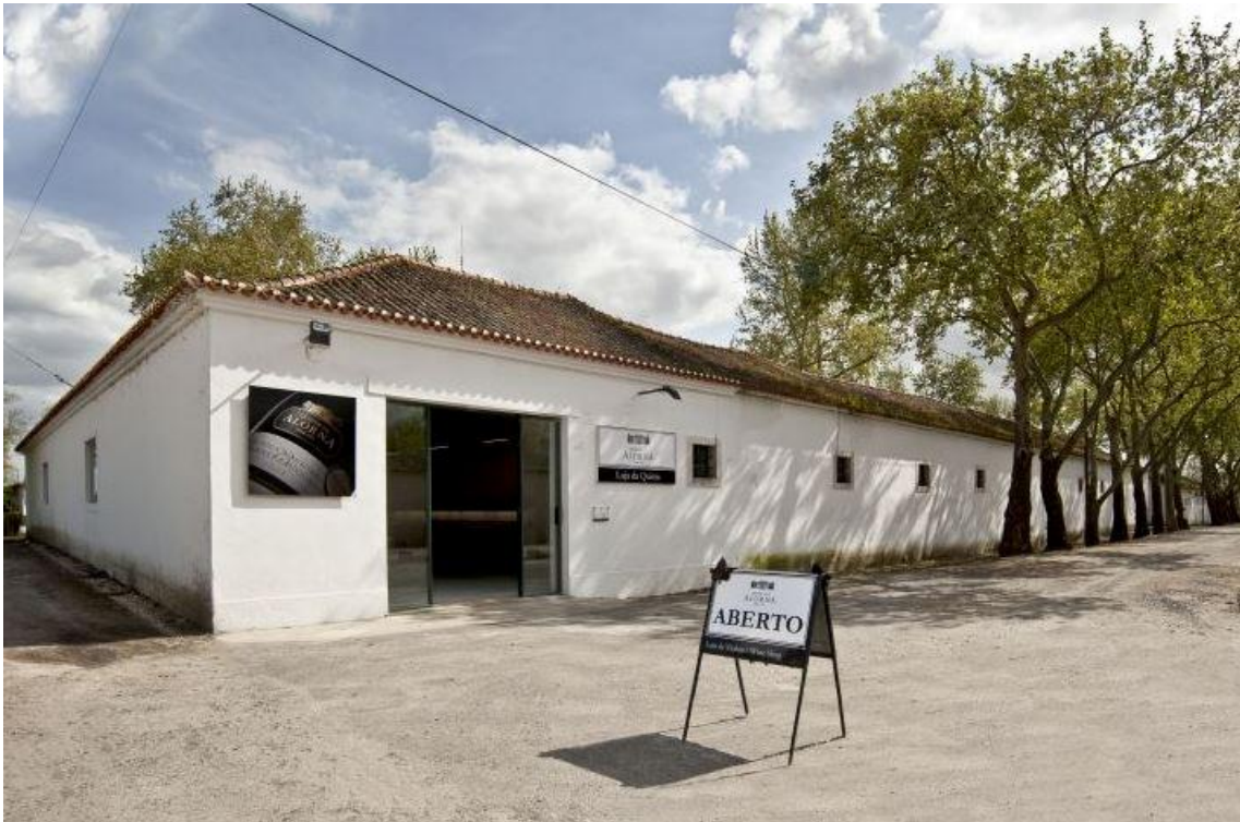
Fig. 52 – Fachada dos edifícios onde se encontra a loja da Quinta
