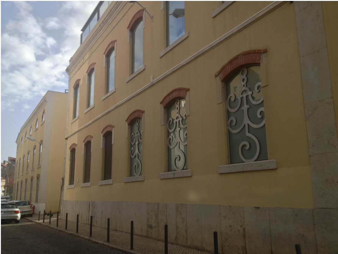
Fig. 58 – Fachada da Rua das Fontainhas
