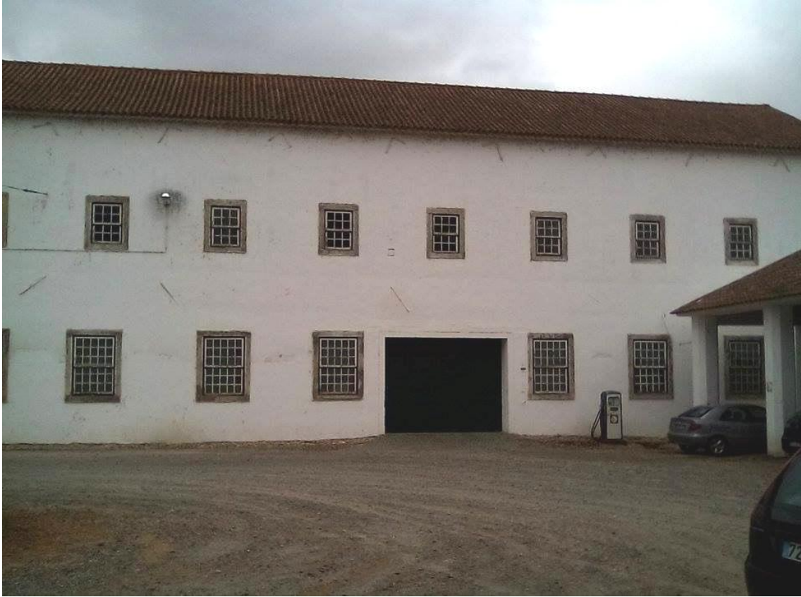
Fig. 35 – Porta larga do edifício.
