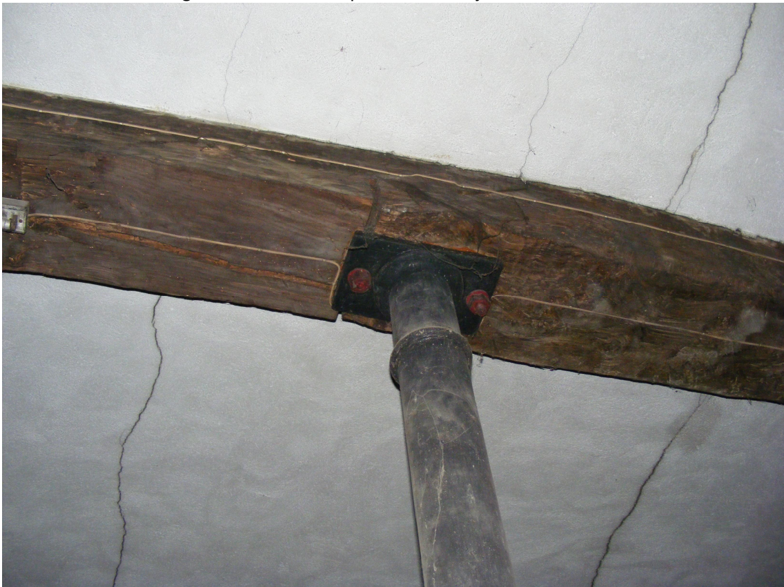
Fig. 41 – Pilar em ferro
