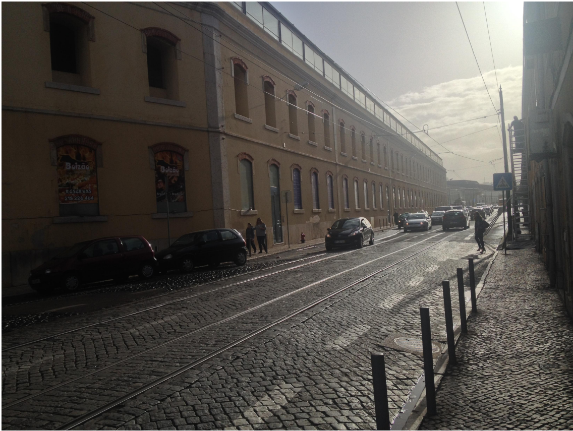
Fig. 56 – Fachada da Rua Fradesso da Silveira
