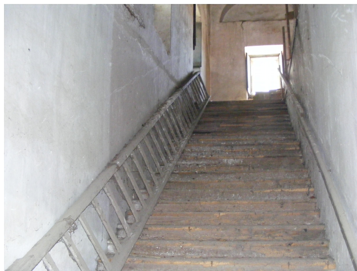
Fig. 44 – Escada de acesso ao piso superior
