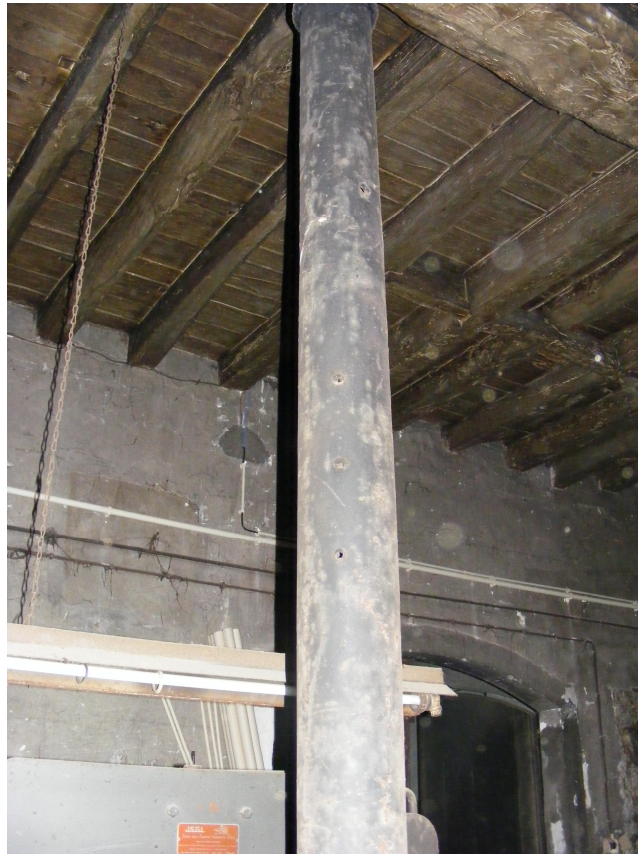
Fig. 39 – Furações para suporte de acessórios nos pilares de ferro
