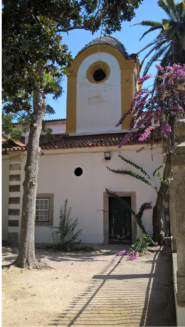
Fig. 18 – Torre de Pombal
