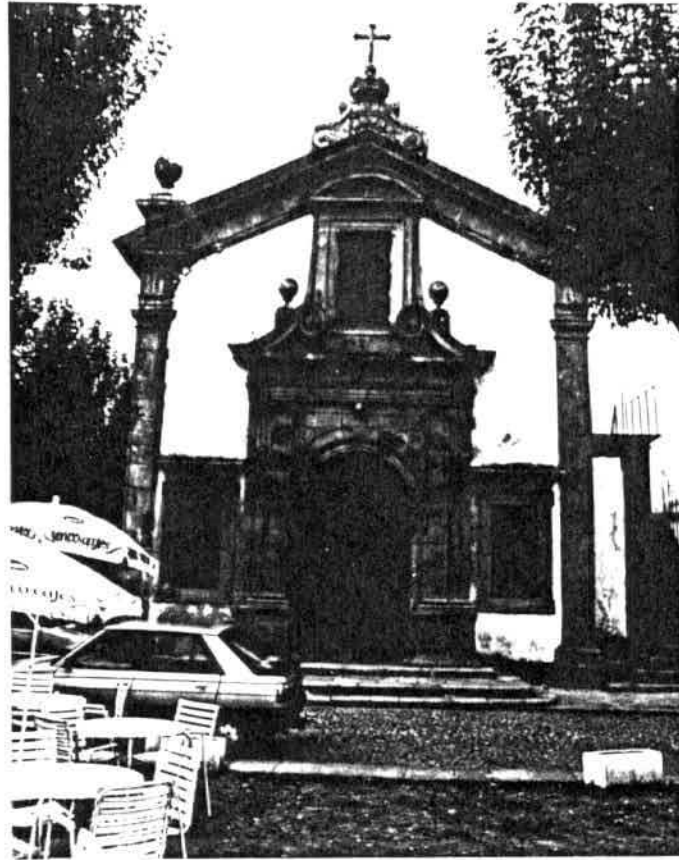
Fig. 40- Capela do Bom Jesus (Valença). Fachada principal.
