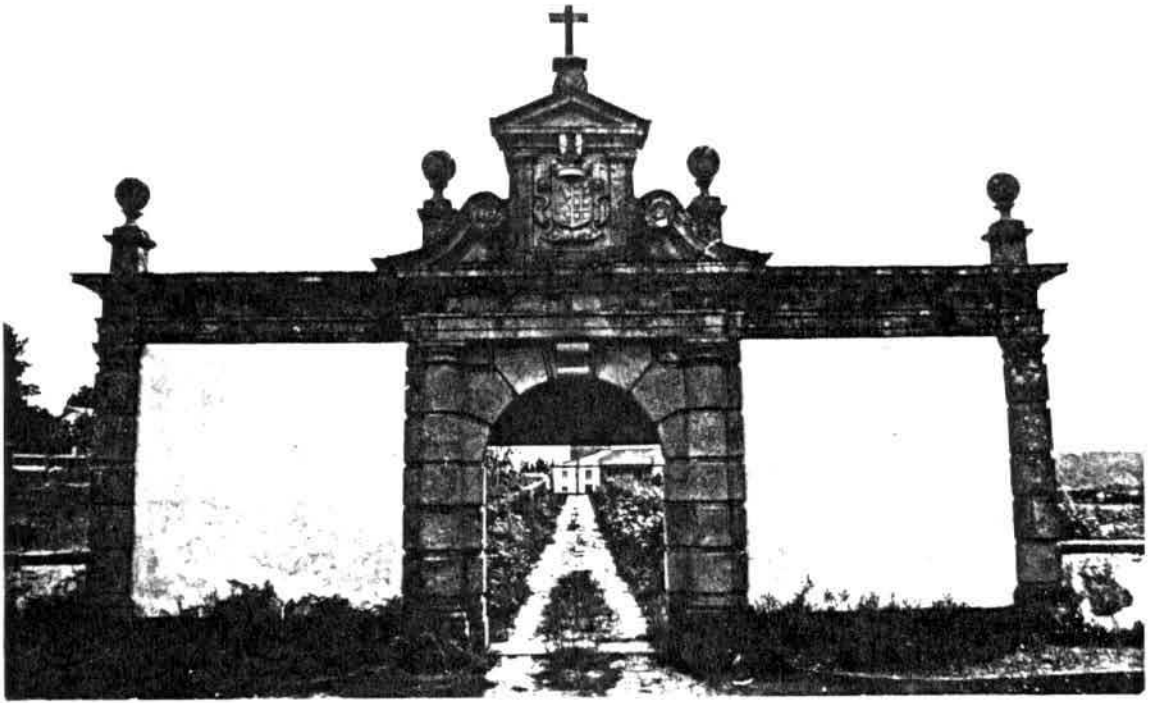
Fig. 74- Casa da Lage. Portal.
