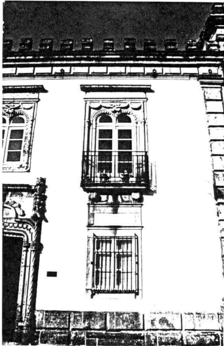
Fig. 68- Casa da Carreira. Janela.
