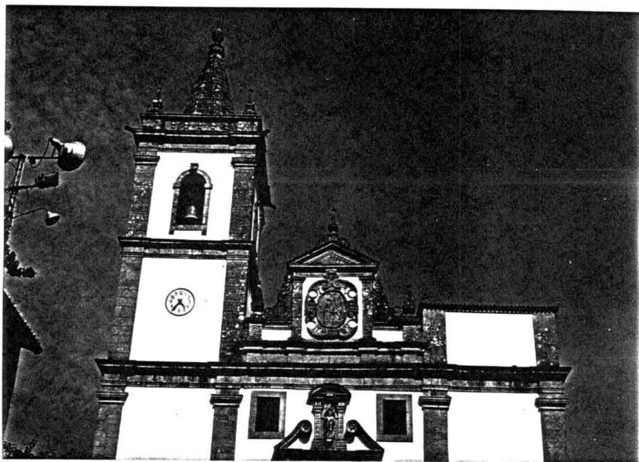
Fig. 10- Igreja matriz de Ponte da Barca. Pormenor da fachada principal.
