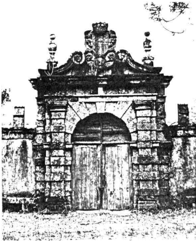
Fig. 75- Paço de Vitorino (Vitorino das Donas, Ponte de Lima). Portal.
