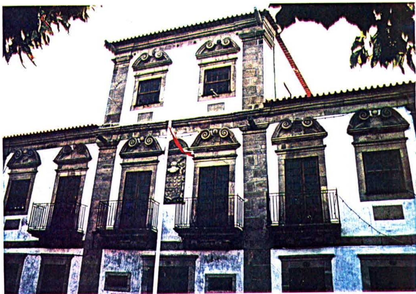
Fig. 62- Casa nobre (Monção). Formenor da fachada principal.
