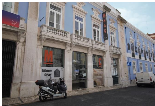
Fig. 13 Fachada do MNAC (Rua Capelo). Foto: Sofia Almeida, 2022
