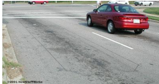
Figura 21 - Circuitos de indução usados para regular a sinalização de semáforos [55]
