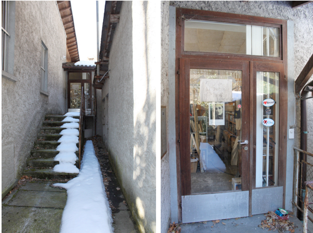
Fig.217 e 218 - Entrada da "Fabbrica Rosa". Maggia, Janeiro 2010.
