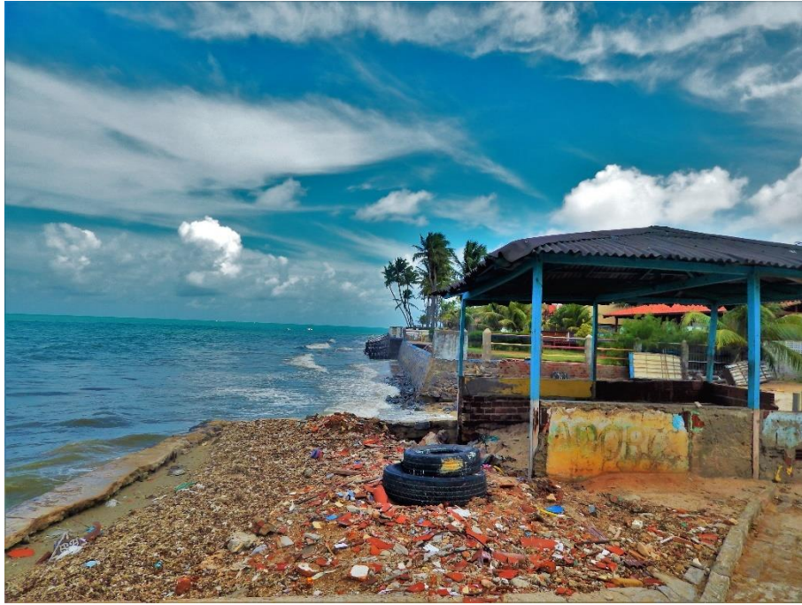
Linha de Costa da Praia de Muriú, Ceará Mirim/RN. Detalhe para estabelecimento comercial abandonado por causa da erosão marinha
