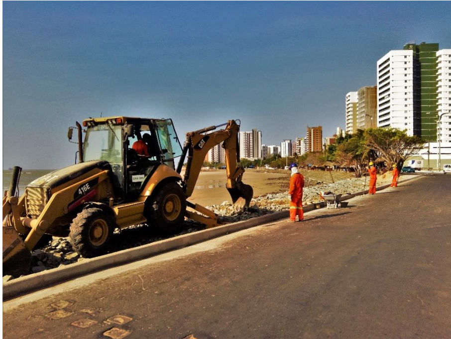
Imagem 19: Andamento de obra pública de reparo da orla e para contenção do avanço do mar. Linha de Costa da Praia da Ponta da Areia em São Luís/MA. 30 de setembro de 2015.
