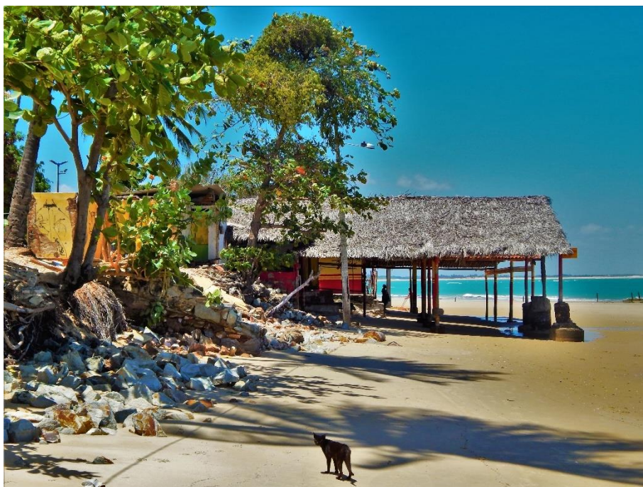
Imagem 15: Erosão Marinha na Linha de Costa de Paracuru/CE, Brasil. Detalhe para destruição em estruturas privadas causada pela erosão marinha. 28 de outubro de 2015
