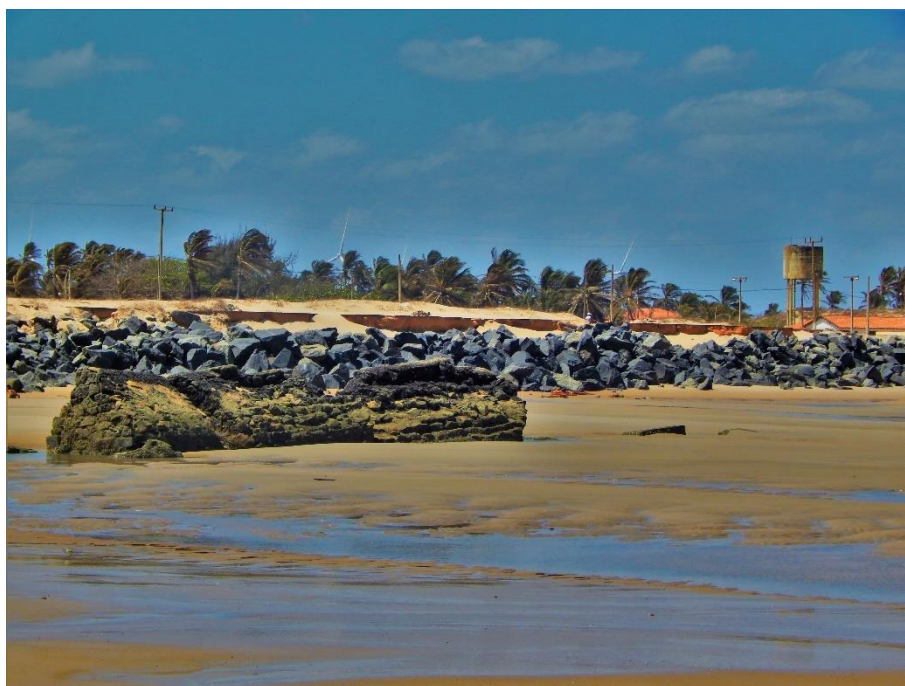
Imagem 13: Erosão Marinha na Praia da Pedra do Sal. Parnaíba/Piauí, Brasil Ruínas de residência destruída pelo avanço do mar e obra de contenção da maré logo atrás. 15 de outubro de 2015
