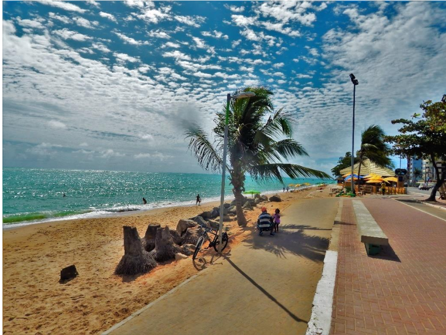
Imagem 14: Erosão Marinha na Linha de Costa da Praia da Ponta Verde em Maceió/AL, Brasil. Detalhe para estrutura rudimentar de contenção da maré.
