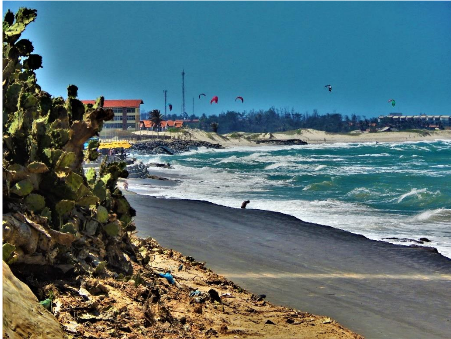
Linha de Costa de Caucaia/CE. Detalhe para reconstrução de avenida litorânea depois de destruição pela Erosão Marinha.
