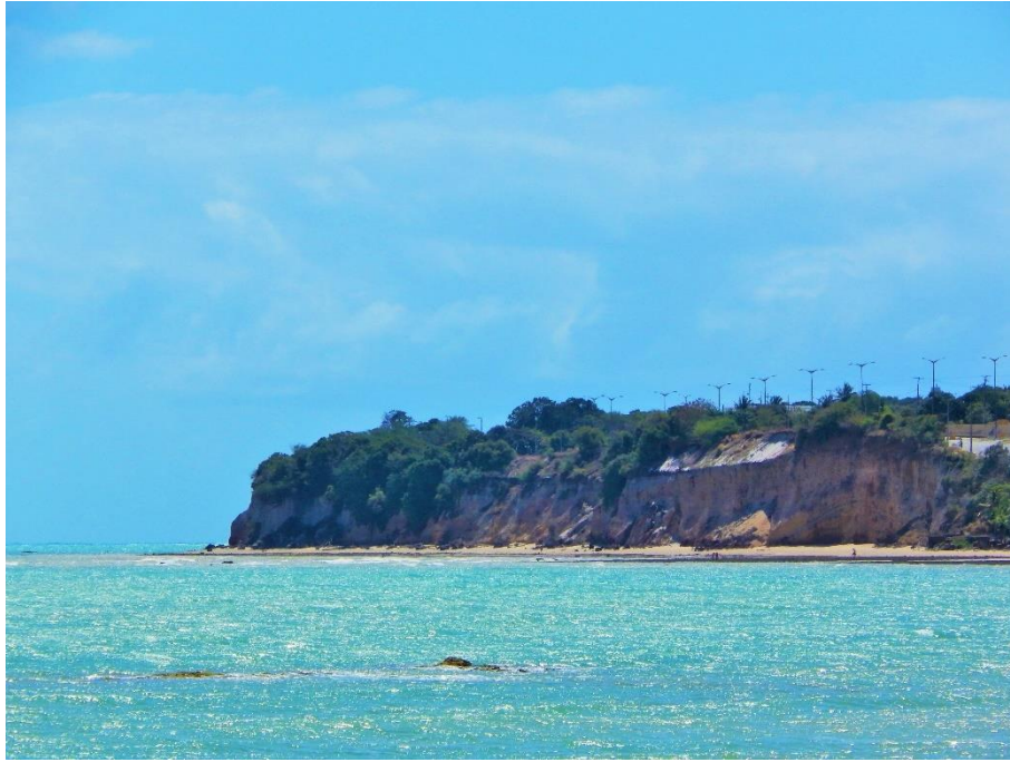
Linha de Costa em João Pessoa/PB vista desde a praia de Cabo Branco. Detalhe para o desabamento de arriba.
