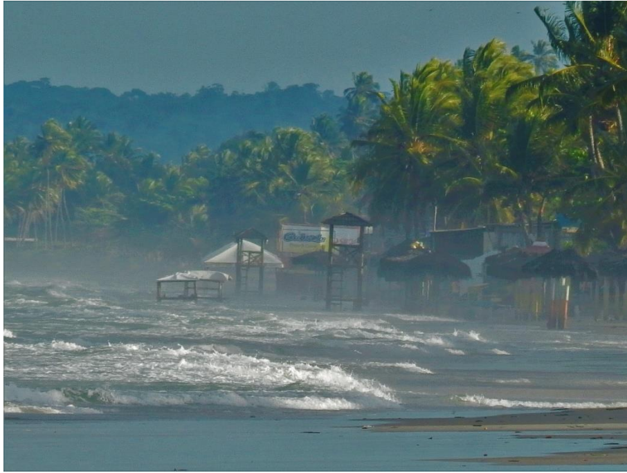
Linha de Costa da Praia dos Milionários em Ilhéus/BA. Detalhe para o avanço do mar nas estruturas de empreendimentos comerciais privados. 28 de setembro de 2015.
