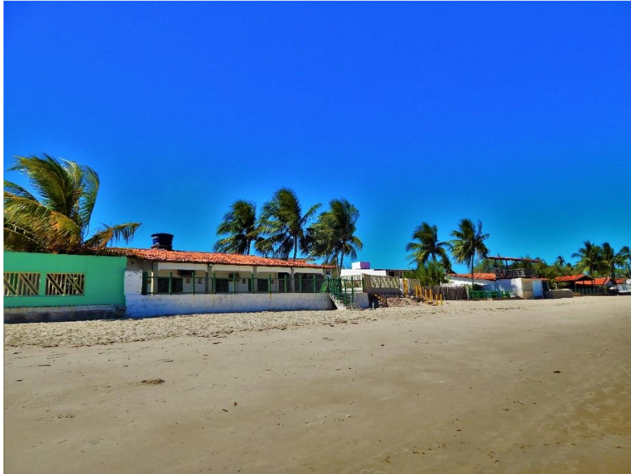
Linha de Costa de Tamandaré/PE. Detalhe para as ocupações que não respeitam a faixa de exclusividade da marinha
