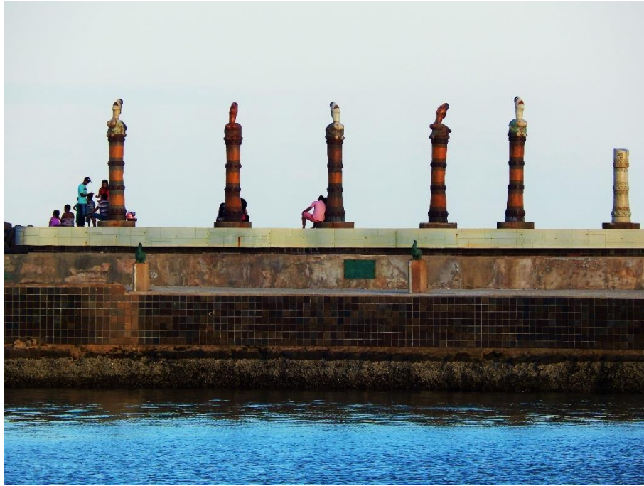
Obra de contenção da maré no Marco Zero em Recife/PE
