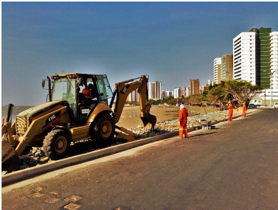
Linha de Costa da Praia da Ponta da Areia em São Luís/MA. Detalhe para andamento de obra pública de reparo da orla e para contenção da maré. 30 de setembro de 2015.
