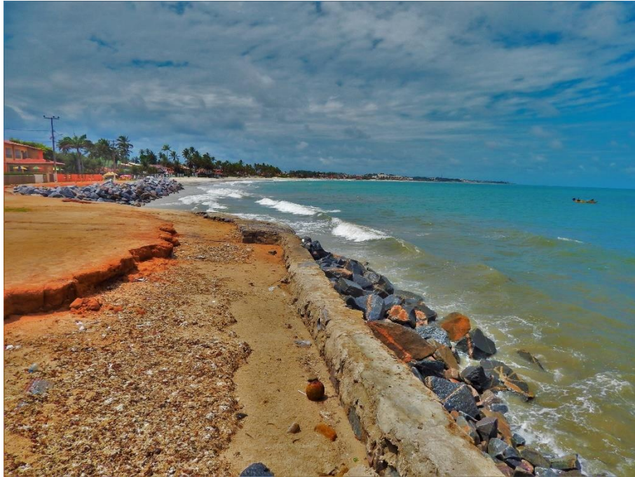
Linha de Costa da Praia de Muriú, Ceará Mirim/RN. Detalhe para obra de contenção da maré e erosão após a obra.
