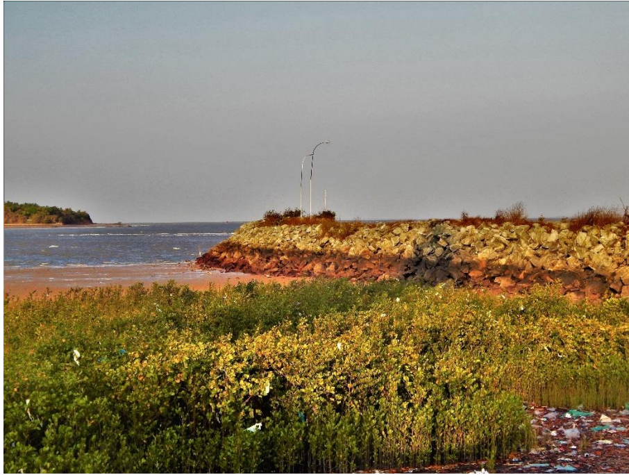
Obra de Contenção da maré em São José do Ribamar/MA. Detalhe para quantidade de resíduos sólidos na vegetação nativa. 1 de outubro de 2015.
