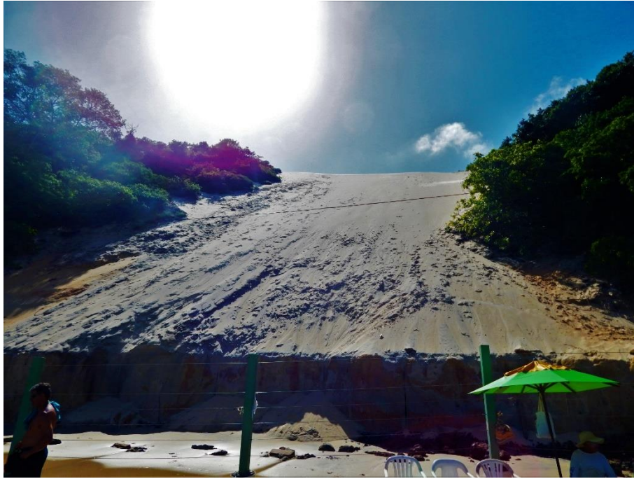
Morro do Careca, Natal/RN. Detalhe para erosão na base do ponto turístico.
