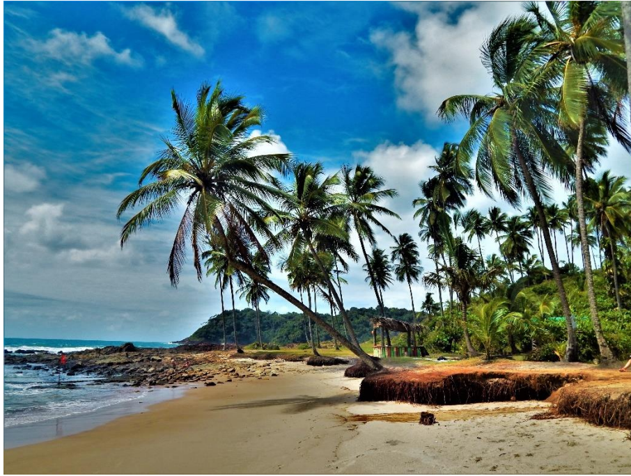
Linha de Costa na Praia do Resende em Itacaré/Bahia. Detalhe para as raízes expostas devido a erosão marinha. 20 de setembro de 2015.
