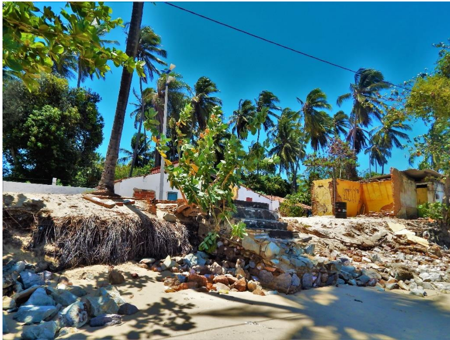
Linha de Costa de Paracuru/CE. Detalhe para destruição em estruturas privadas causada pela erosão marinha.
