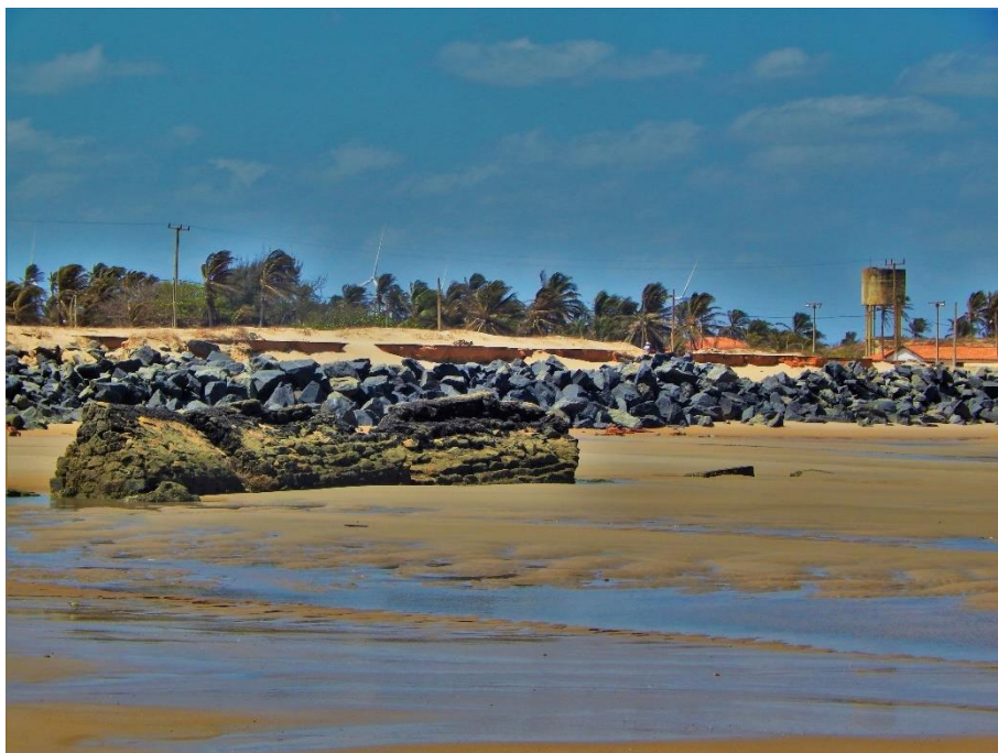
Praia da Pedra do Sal, Parnaíba/Piauí. Ruínas de residência destruída pelo avanço do mar e obra de contenção da maré logo atrás. 15 de outubro de 2015
