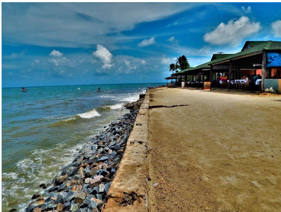
Linha de Costa da Praia de Muriú, Ceará Mirim/RN. Detalhe para obra de contenção da maré.
