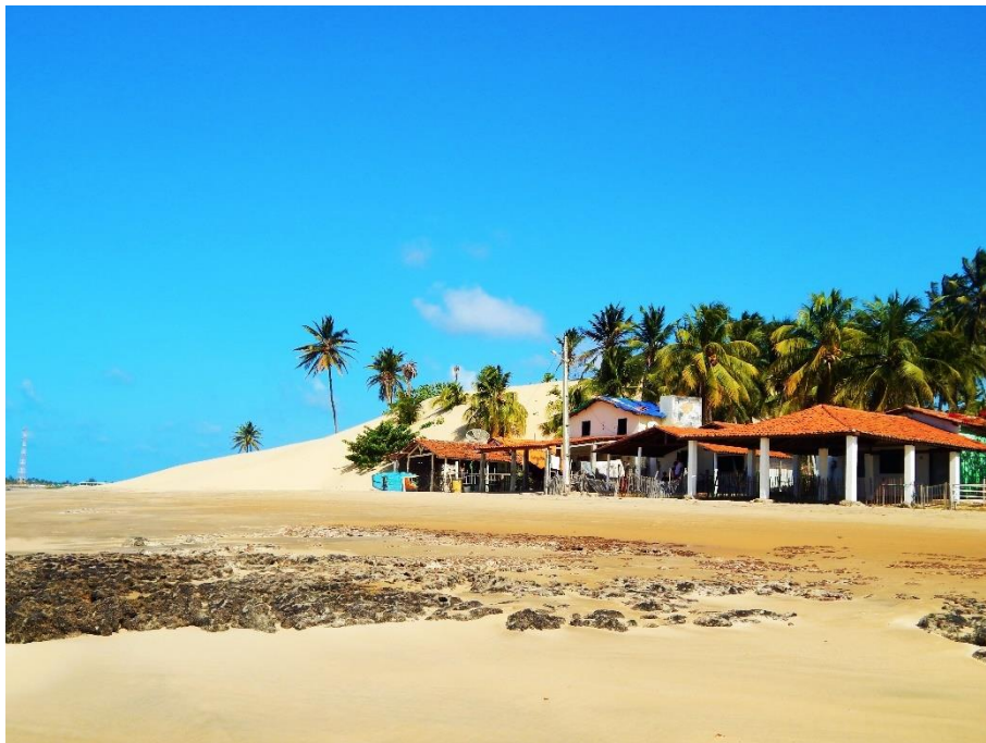
Paracuru/CE. Ocupação irregular na faixa exclusiva da marinha
