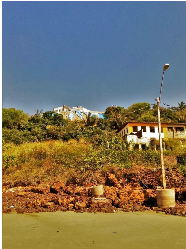
Linha de Costa da Praia do Olho D'Água em São Luís/MA. Detalhe para dois desastres naturais: Erosão marinha que derrubou estrutura pública e deslizamento de terra mais acima onde lonas de plástico azuis protegem propriedade privada 30 de setembro de 2015.
