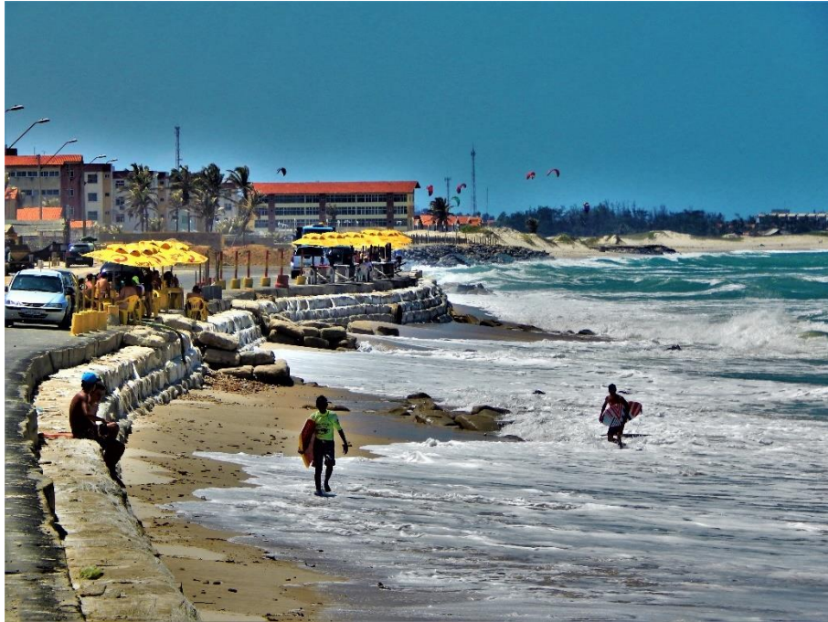
Linha de Costa de Caucaia/CE. Detalhe para reconstrução de avenida litorânea depois de destruição pela Erosão Marinha e obra de contenção da maré.
