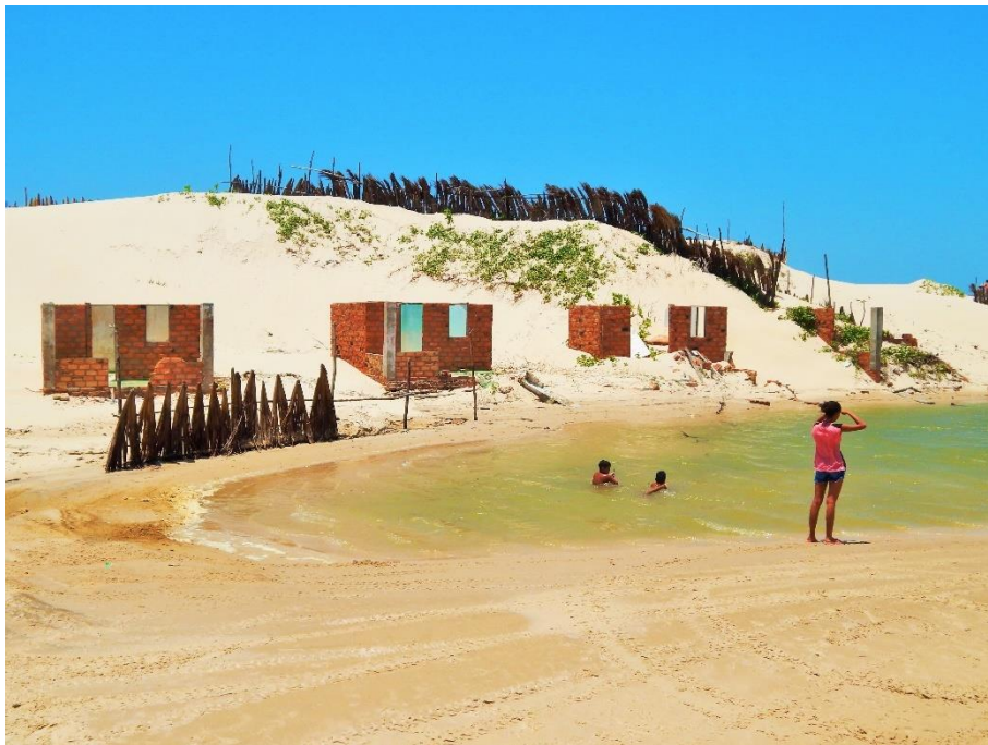
Ocupação em Atins, Barreirinhas/MA. Detalhe para soterramento devido avanço das Dunas. 4 de outubro de 2015.
