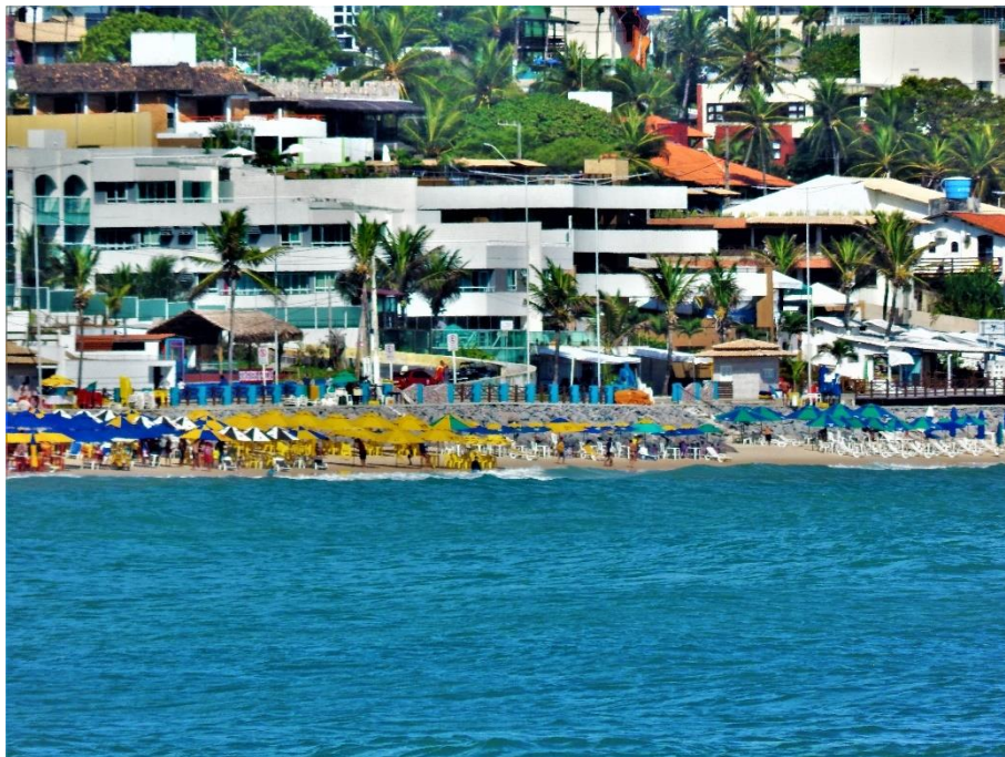
Linha de Costa da Praia de Ponta Negra, Natal/RN. Detalhe para obra de contenção da maré.
