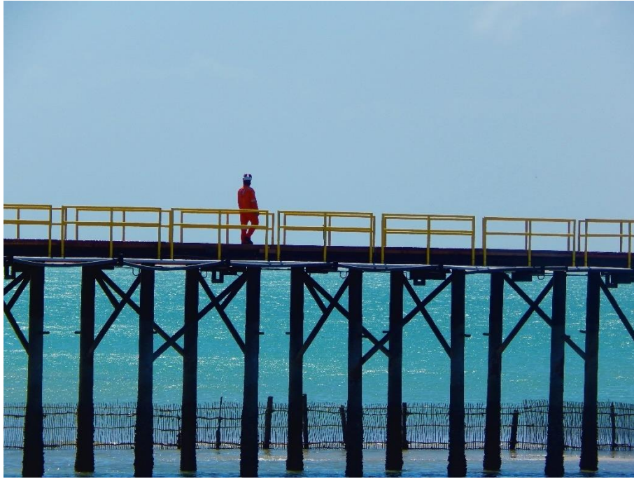
Paracuru/CE. Pier da Petrobrás S.A
