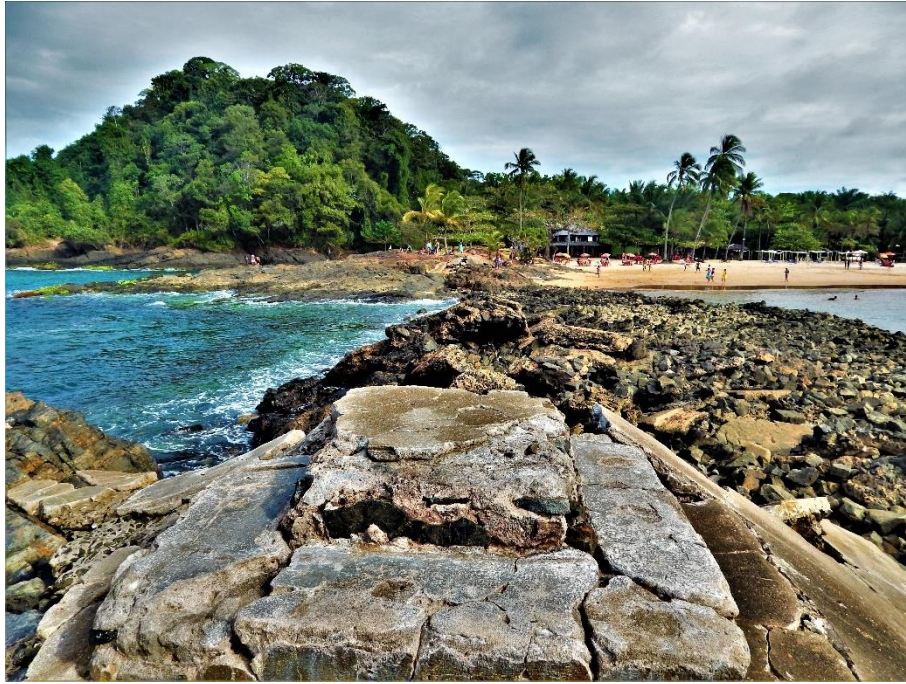
Vista da Praia da Concha em Itacaré/Bahia desde o farol. Detalhe para destruição da passarela que permitia a chegada ao farol e servia com espigão para contenção da maré 20 de setembro de 2015.
