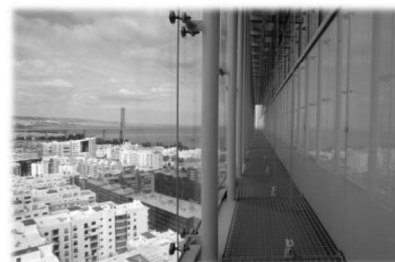
Figura 9 - Fachada de dupla pele - Edifício H do Office Park Expo (Fonte LNEC)
