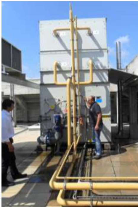
Figura 3.2 Torre de refrigeração do gás R404.
