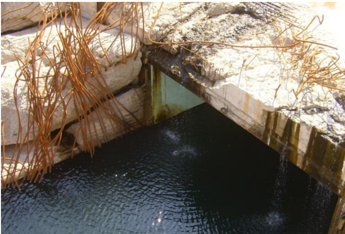
Figura D.6.6 - Descarga de fundo após o acidente de 2008 (arquivo pessoal de Eng° João Marcelino).
