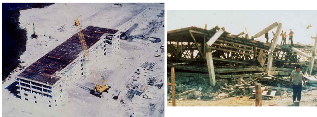
Figura 2.2 – Harbour Cay Condominium antes e após o colapso, Delatte (2009).
