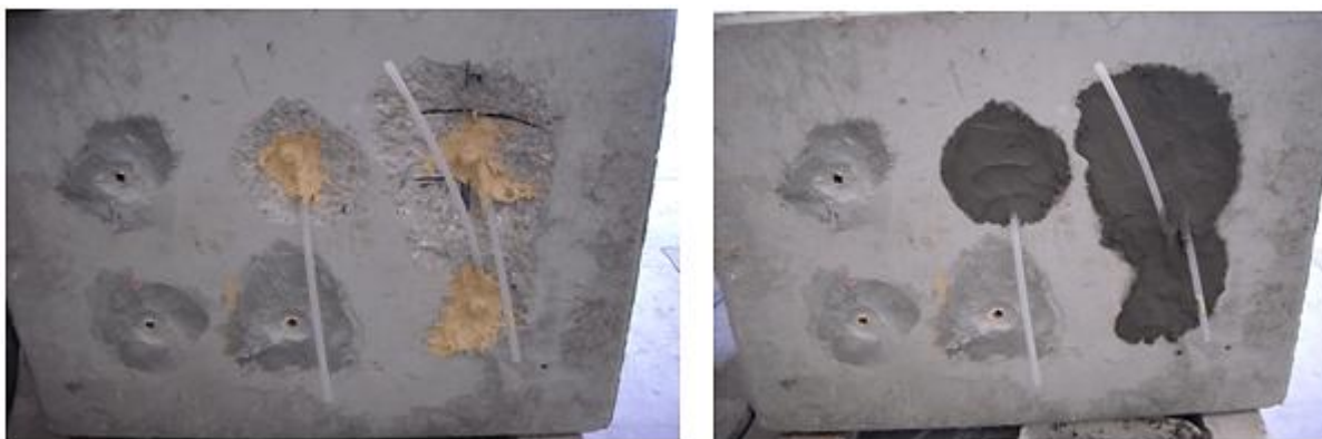
Fig. 97 - Aparência da ancoragem após aplicação de betume de pedra (esq.) e aspecto final (dta.)
