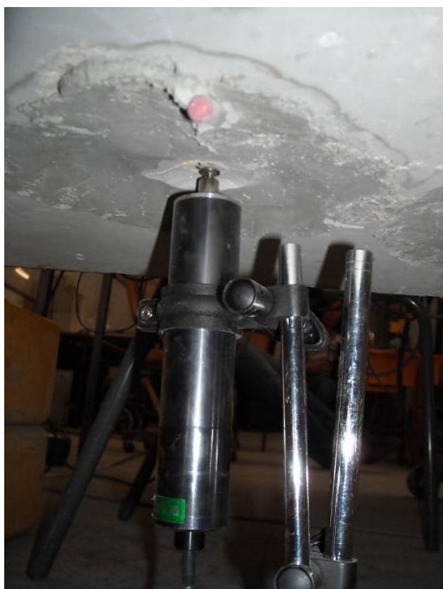
Fig. 91 - Defletoímetro colocado directamente no fundo da ancoragem
