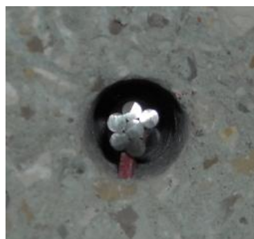
Fig. 101 - Aplicação de um espaçador em resina de maior espessura
