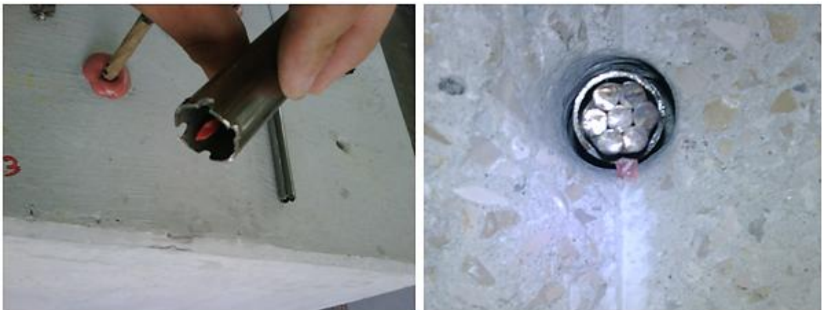
Fig. 103 - Coroamento da extremidade do tubo (esq.) e aplicação na ancoragem (dta.)
