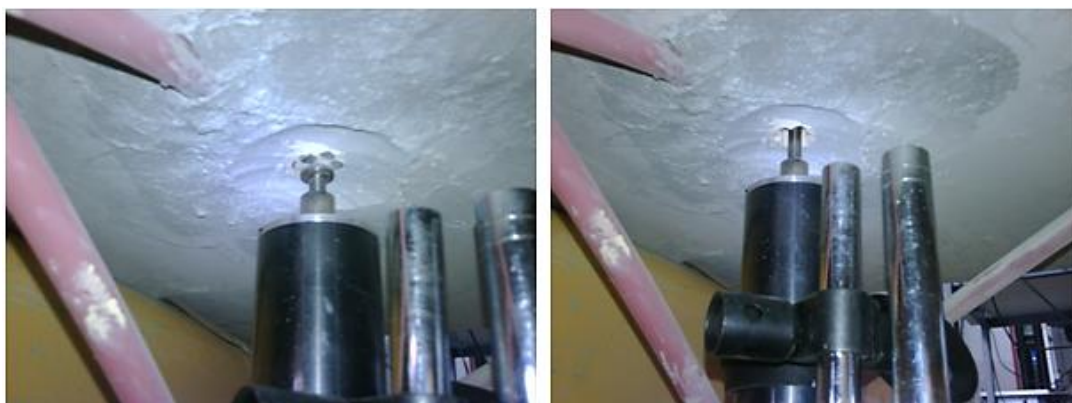
Fig. 115 - Colocação de deflectómetro directamente na ancoragem (esq.) e aparência após ensaio (dta.)
