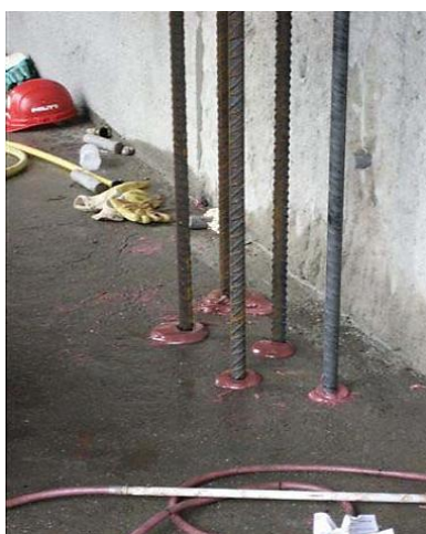
Fig. 35 - Aplicação prática de ancoragens pós-instaladas [85]
