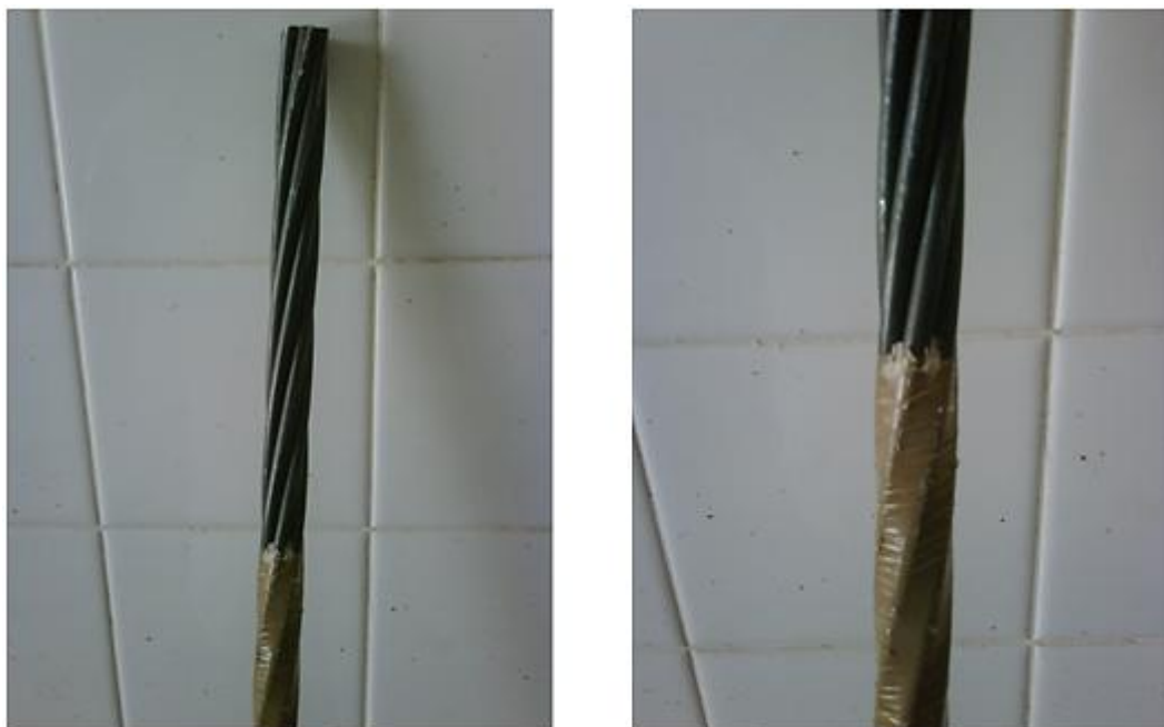
Fig. 94 - Preparação do troço não aderente dos cordões
