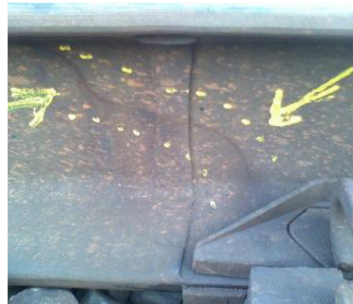
Figura 4.12 - Fenda transversal em carril, adaptado (Rodrigues, 2012)
