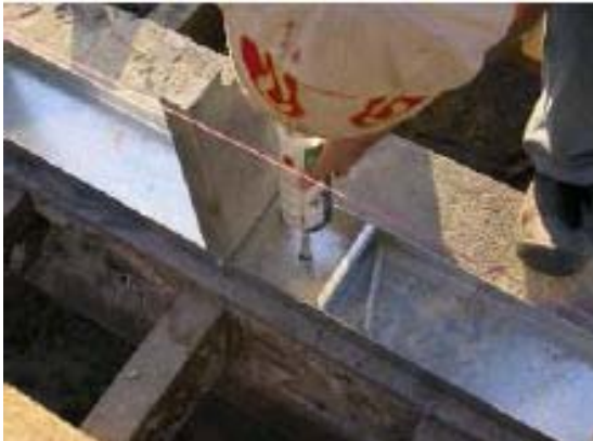
Figura 4: Colocação de bucha química
