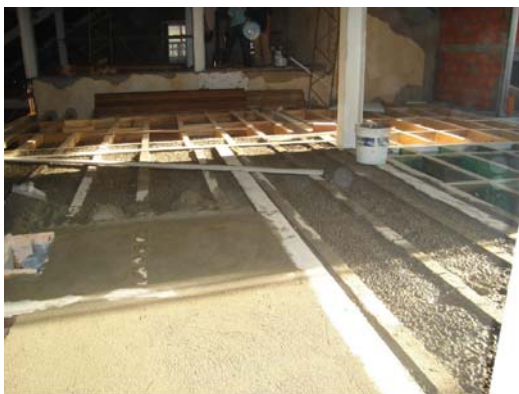
Figura 6: Preenchimento do espaçamento entre vigas de madeira com betão de agregados leves
