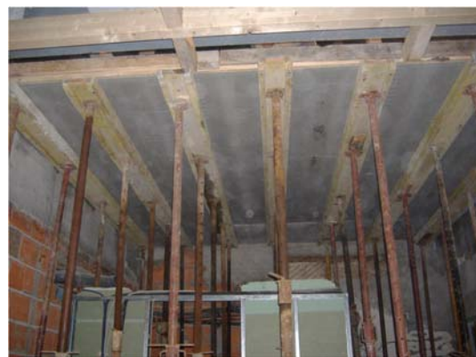
Figura 7: Escoramento de uma laje mista de madeira-betão
