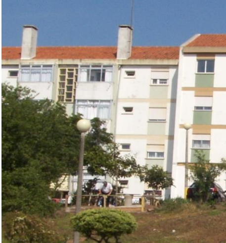
Fotografias 93 - Mesa construída pelos moradores
