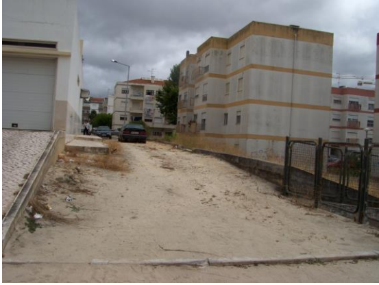
Fotografia 49 - Rua José Tanganho -pormenor do caminho de terra batida
