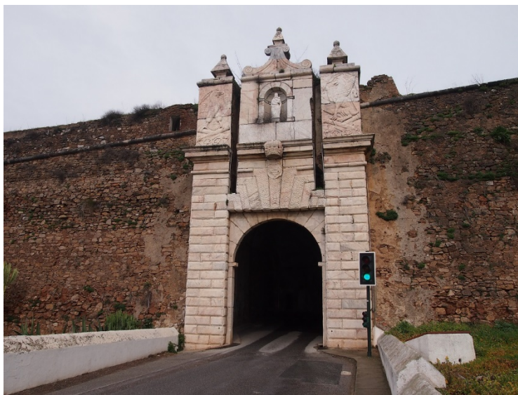
Figura 22. Porta dos Currais - Portal. Foto do autor
