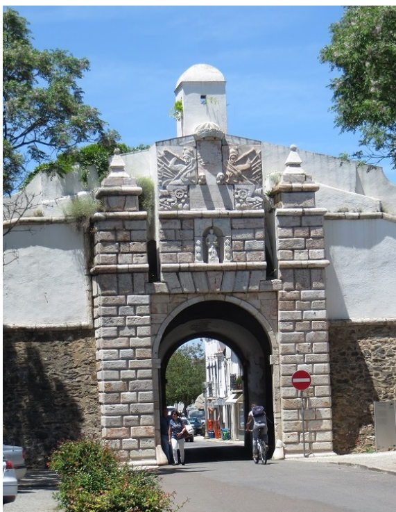
Figura 25. Porta de Santo António - Portal. Foto do autor
