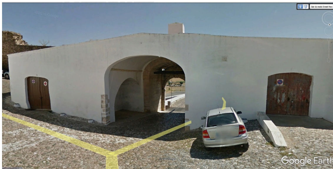
Figura 30. Porta de Évora - Trânsito e Corpos da Guarda. Imagem GoogleEarth
