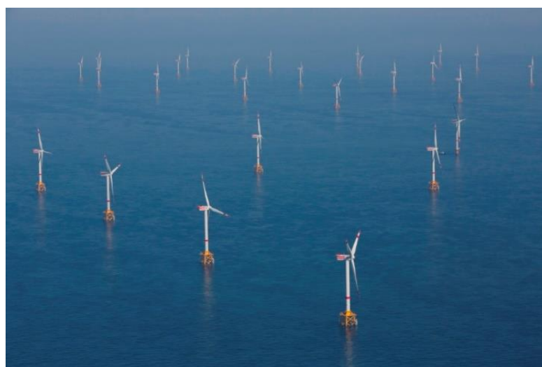
Figura 2.2 - Vista aérea do parque eólico Thornton Bank (Bélgica) [20]
