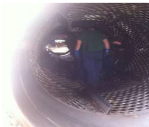
Figura 28 - Trommel de lavagem em manutenção (Fonte: Querido, D. 2015)
