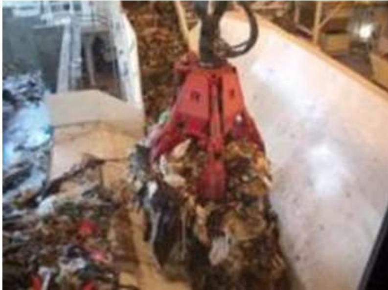
Figura 16 – Grua com garra para transporte de RU (Fonte. VALNOR)
