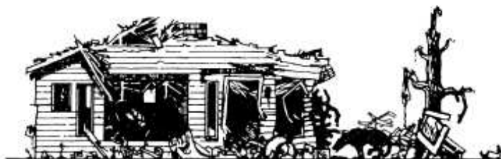
D. Depois da passagem da onda de choque.
