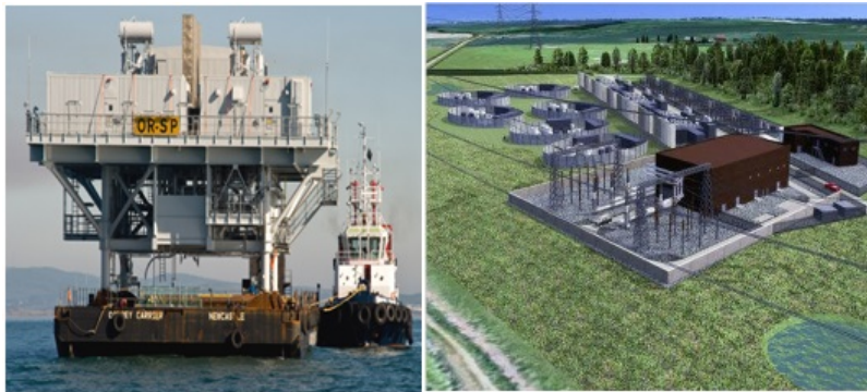
Figura 2.12: subestações eléctrica offshore e onshore , figura adaptada de[12].
