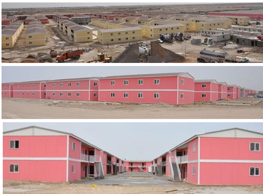
Figura 2.15 – Conjunto de habitações modulares pré-fabricadas após a sua montagem no local (Karmod, 2016)
