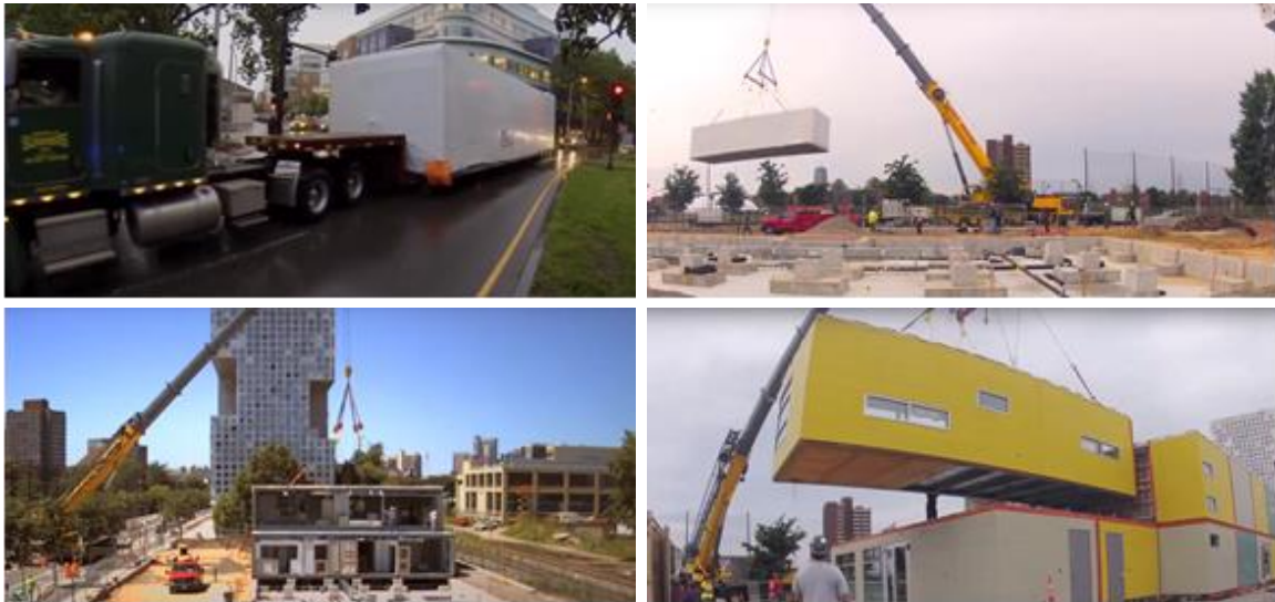
Figura 2.12 – Construção da creche – Transporte e colocação dos módulos pré-fabricados (Triumph, 2016)
