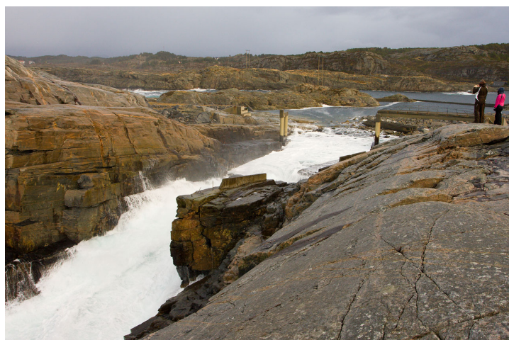
Figura 2.5: Conversor de galgamento - TapChan (Les-Pins 2011).
