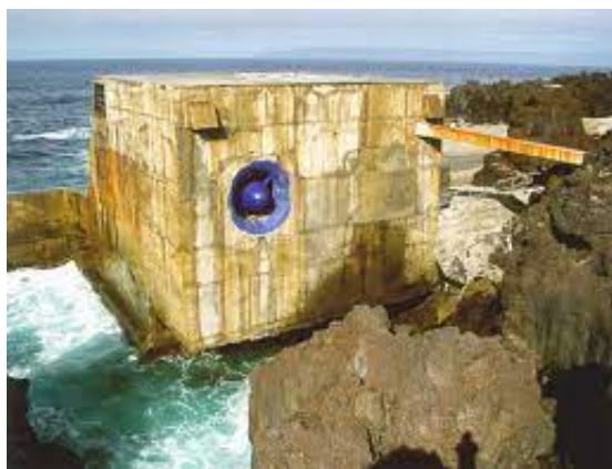
Figura 2.4: Conversor CAO instalado na Ilha do Pico, nos Açores (Noctula 2014).
