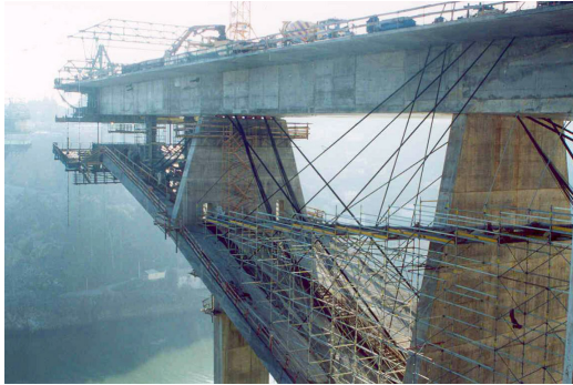
(a) Cabos temporários na construção da ponte Infante D. Henrique, Porto [5]
