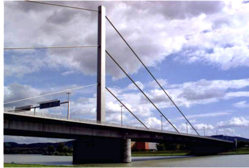
(b) Tirantes da ponte Vöestbridge, Linz, Áustria [15]
