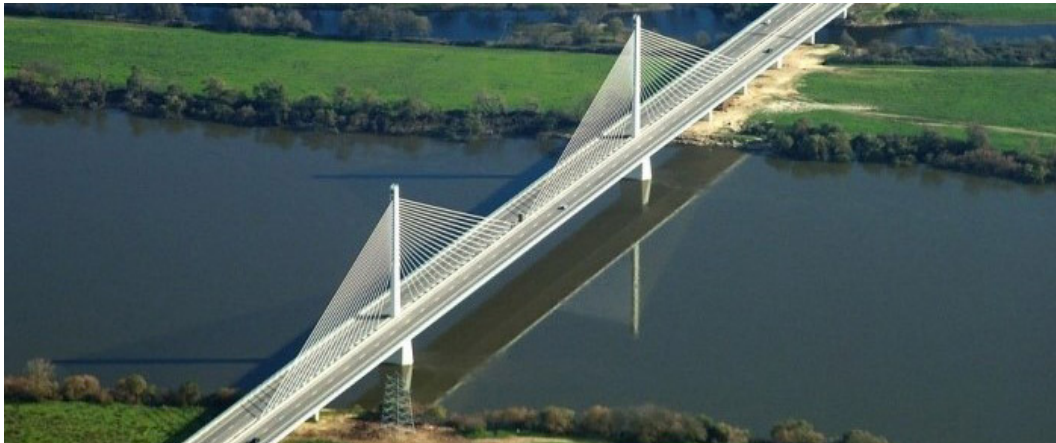
Figura 3.1: Ponte Salgueiro Maia [20]
