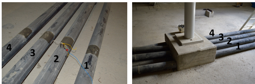
Figura 3.21: Numeração dos cabos de pré-esforço exterior ensaiados
