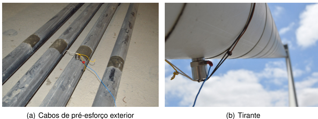
Figura 3.16: Ligação do acelerómetro aos elementos na primeira visita à Ponte Salgueiro Maia
