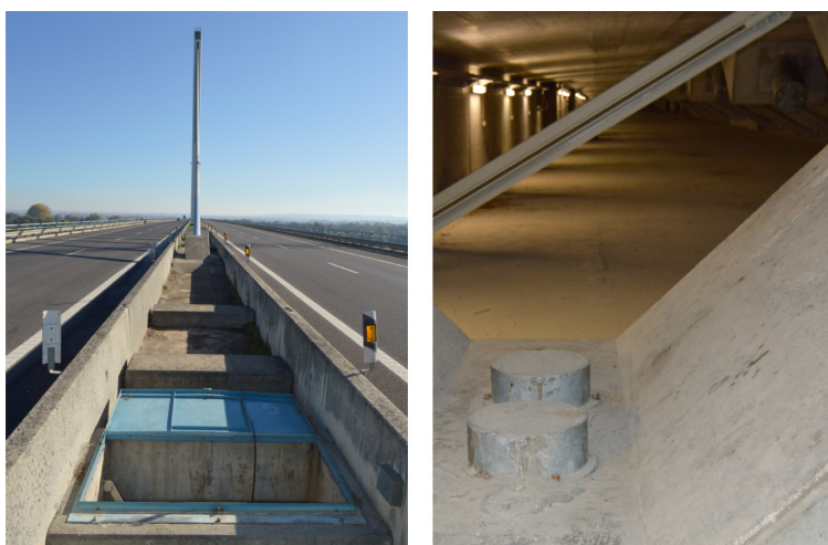
Figura 3.11: Acesso vertical e iluminação interior do tabuleiro da ponte
