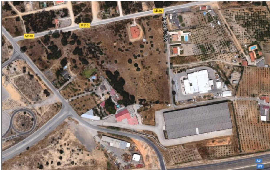
Figura 11 - Localização da instalação fotovoltaica em estudo
