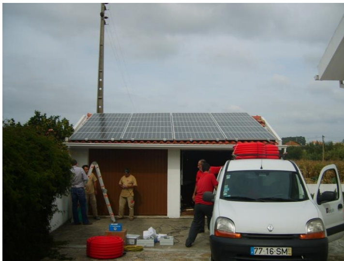
Figura 3.4 – Trabalhadores numa instalação de microgeração da empresa Bongás, Lda.
