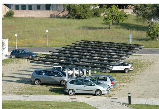
Figura 2.18 – Parque de estacionamento fotovoltaico do Edifício Solar XXI
