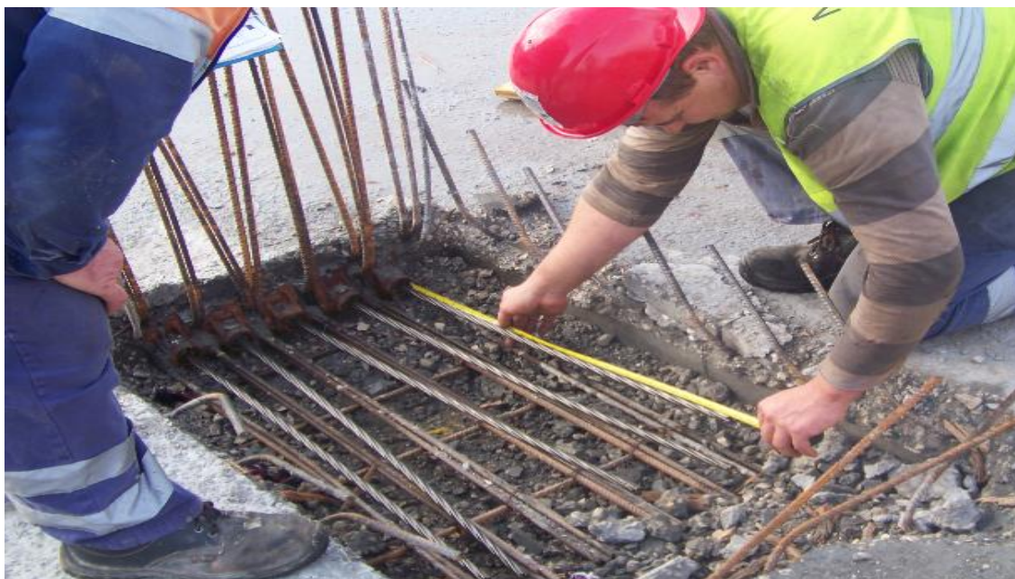
Figura 2.20 – Medição dos comprimentos dos cordões antes do tensionamento
