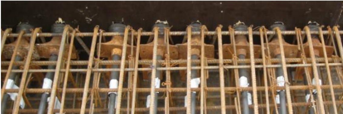
Figura 4.4 - Disposição das ancoragens em obra (Luanda 2012).
