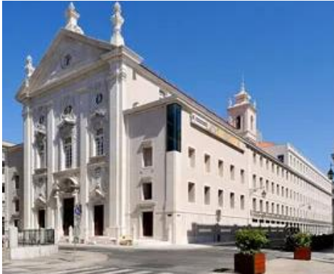
Figura 1- Edifício sede do Banco de Portugal
